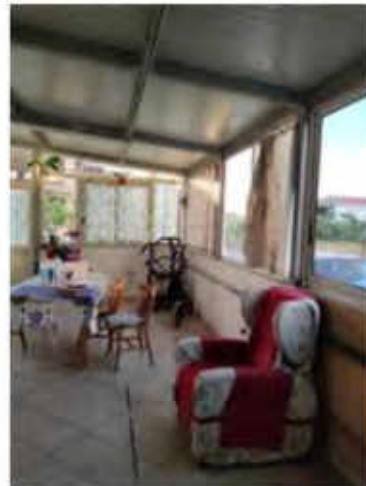
Foto interno veranda da ripristinare
