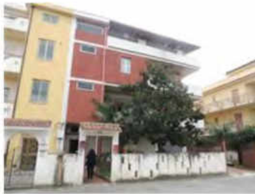
Foto esterno da Via Alcide De Gasperi
