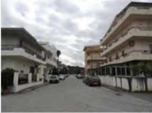
Foto su Via G. Matteotti verso Sud-Est
