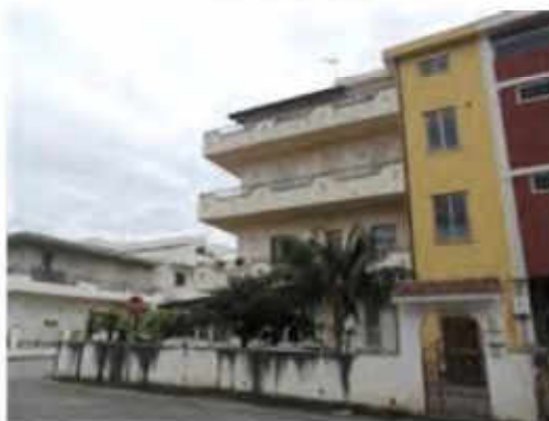
Foto esterno ingresso da Via Alcide De Gasperi
