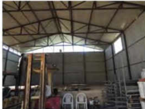
Foto interno capannone metallico
