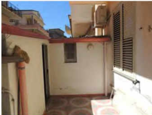
Foto forno da ripristinare
