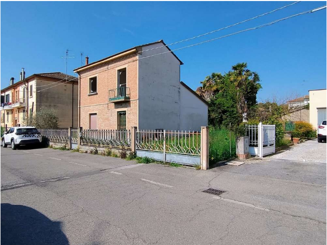
Fronte Via Canelli
