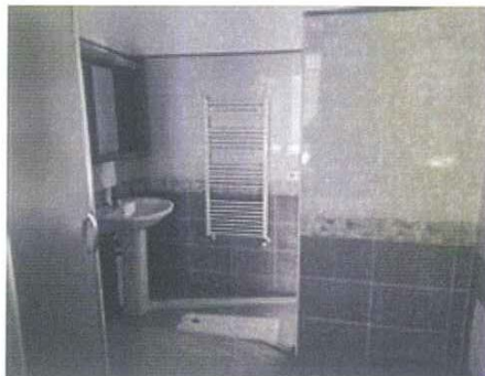
Bagno - i termosifoni presenti al piano sono alimentati dal termo camino
