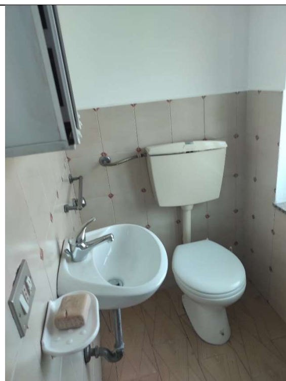
FOTO 18 Piano mansardato - bagno
