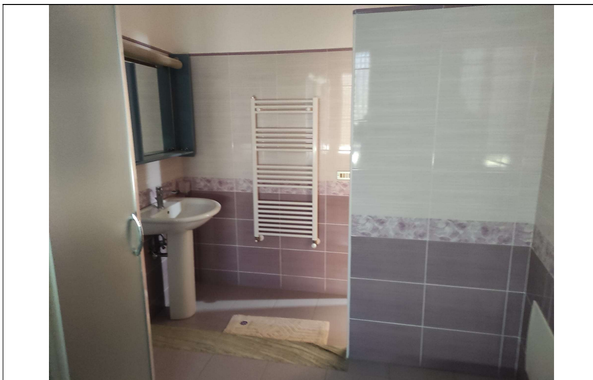
FOTO 15 P.1 - Particolare bagno
