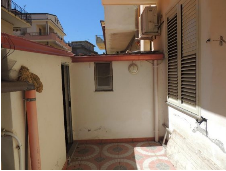
Locale di sgombero – Forno
