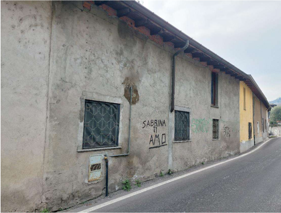
Figura 3 - Prospetto nord dell'edificio
