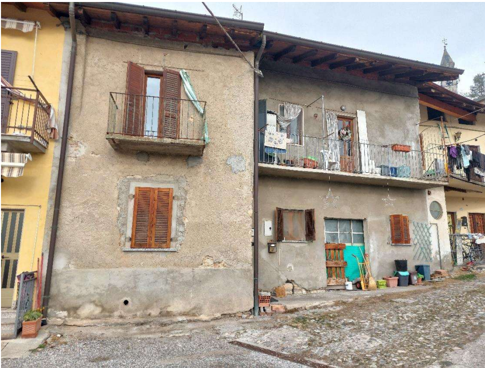
Figura 1 - Prospetto sud dell'edificio
