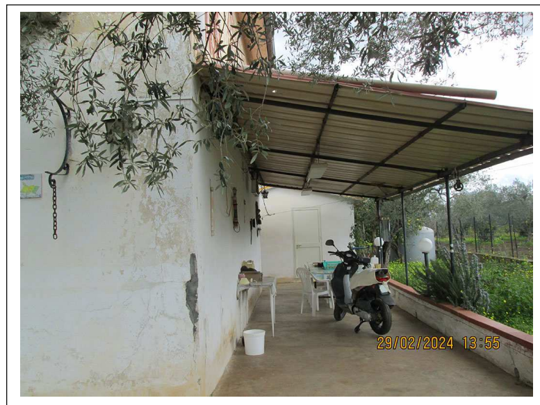
Foto n. 43. Tettoia in lamiera, lato sud-est.
