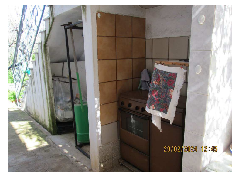
Foto n. 38. Zone deposito sotto la scala di accesso al piano primo.
