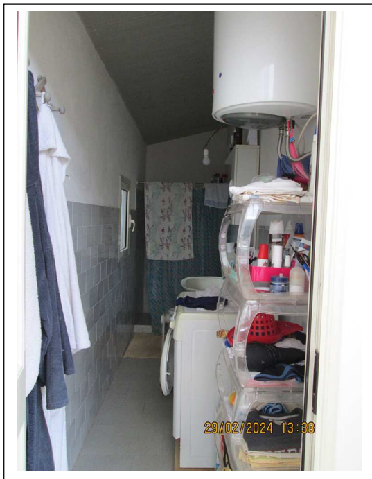
Foto n. 36. Corpo edilizio sul lato nord-est del lotto. Servizio igienico.
