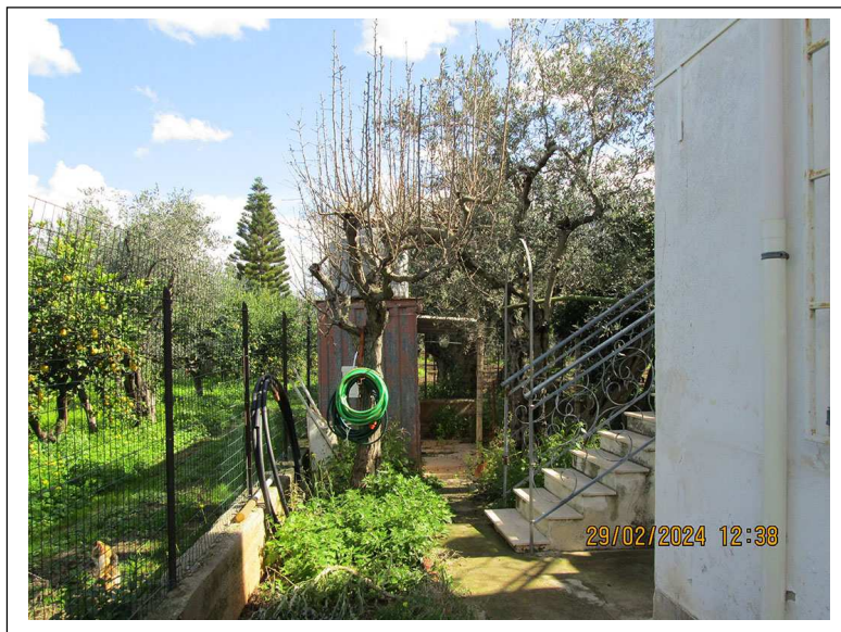
Foto n. 19. Giardino lato nord ovest. Sullo sfondo è visibile il manufatto in lamiera
