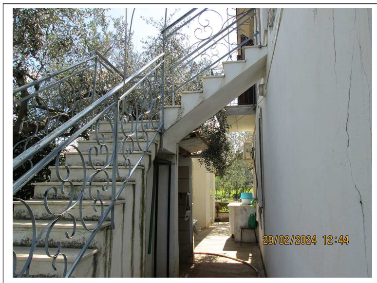
Foto n. 20. Scala di accesso al primo piano.
