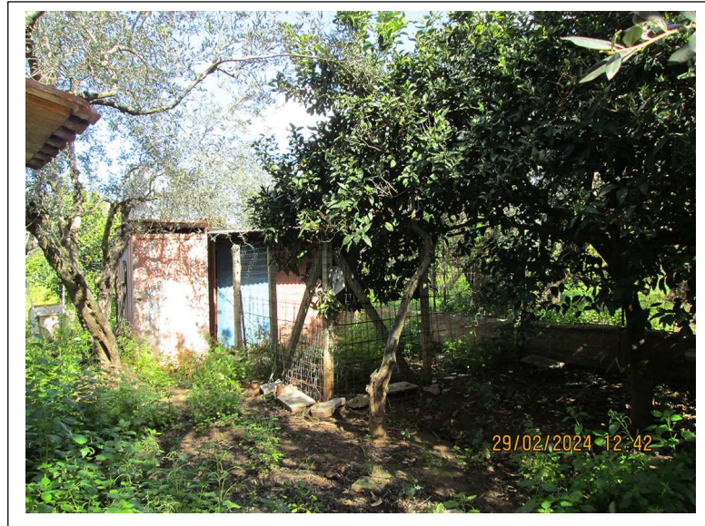
Foto n. 42. Manufatto in lamiera, lato nord-ovest.
