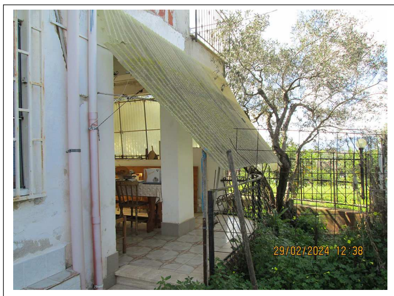
Foto n. 18. Portico lato nord-ovest.
