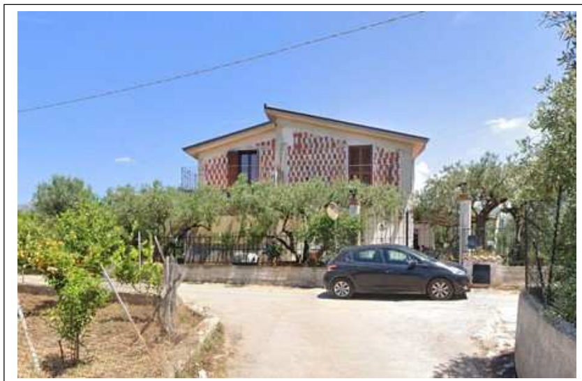
Foto n. 1. Veduta del villino tratta da Google street.
