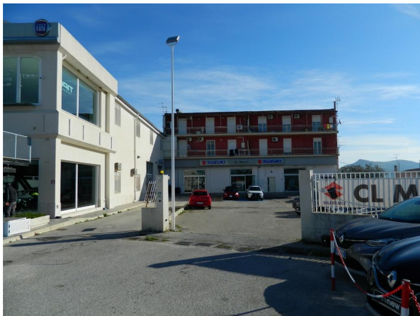
Particolare Ingresso carrabile area condominiale parcheggio
