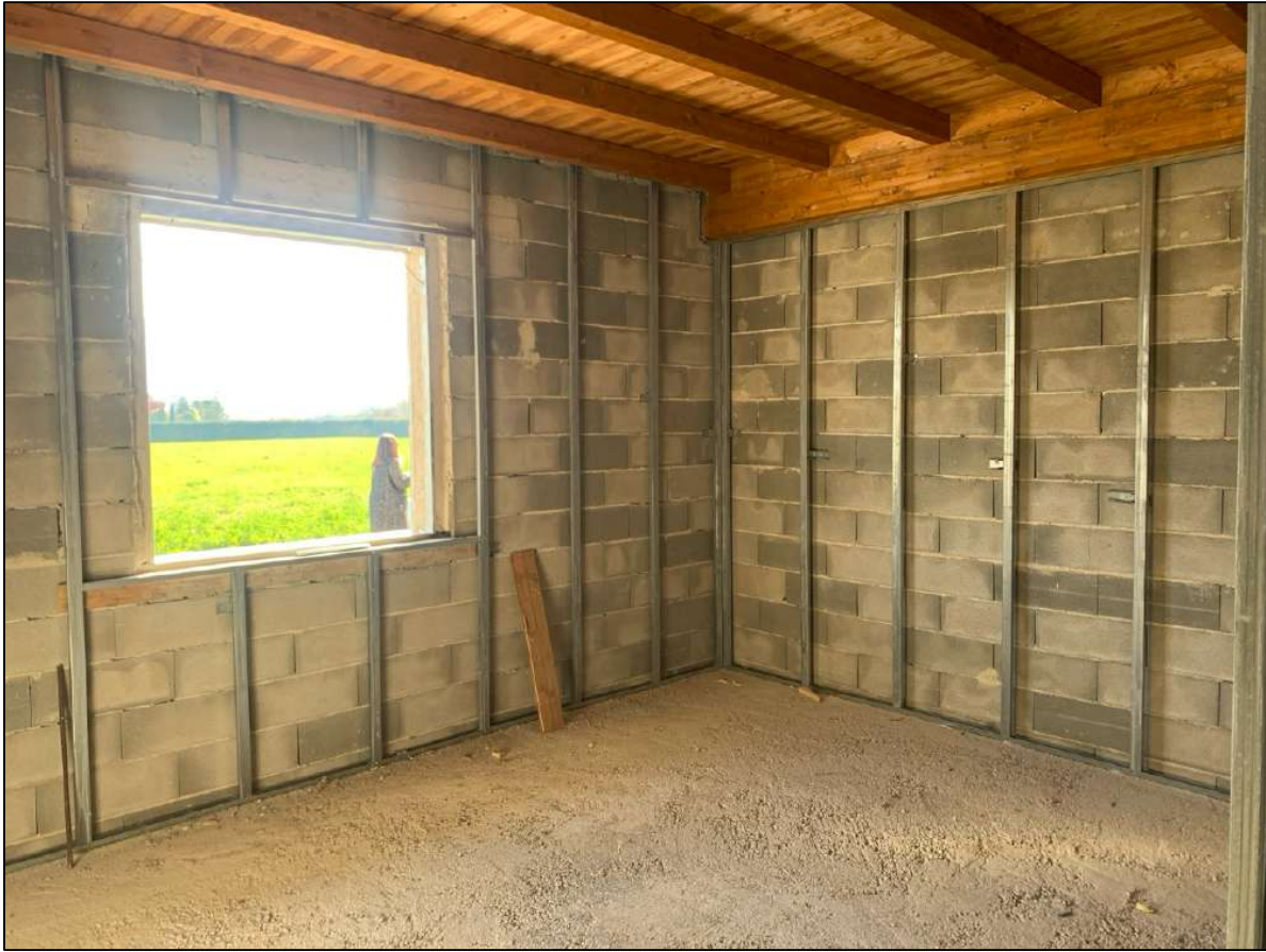
Terreno a Ferentino - Fabbricato in muratura grezza (interno)
