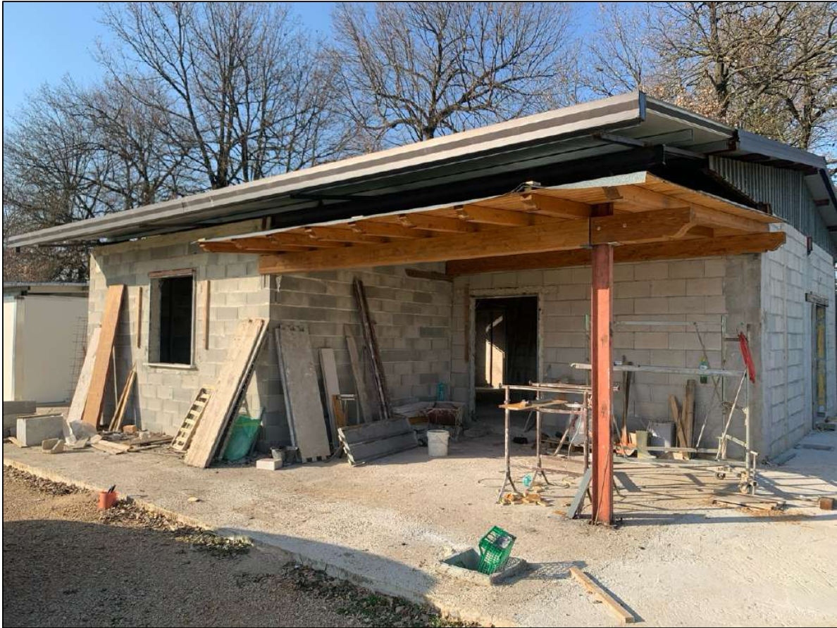
Terreno a Ferentino - Fabbricato in muratura grezza (in corso di costruzione)
