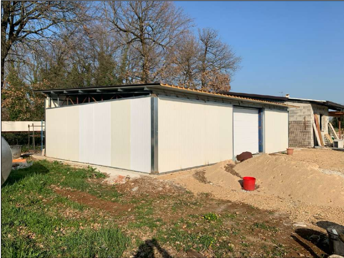
Terreno a Ferentino - deposito realizzato con pannelli isopan
