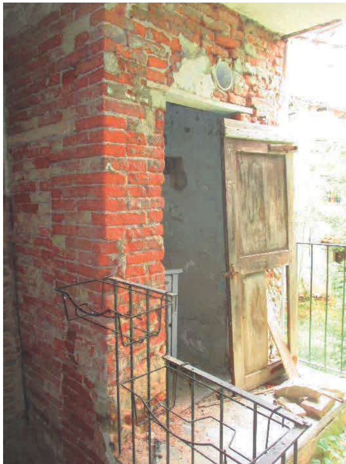
FOTO N. 23 – F. 9 MAPP. 377 SUB.1 – RIPOSTIGLIO A P. PRIMO – LOTTO 1
