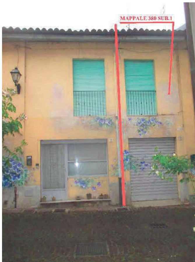
FOTO N. 33 – F. 9 MAPP. 380 SUB.1 – ABITAZ. – VIA FONTANA – LOTTO 1
