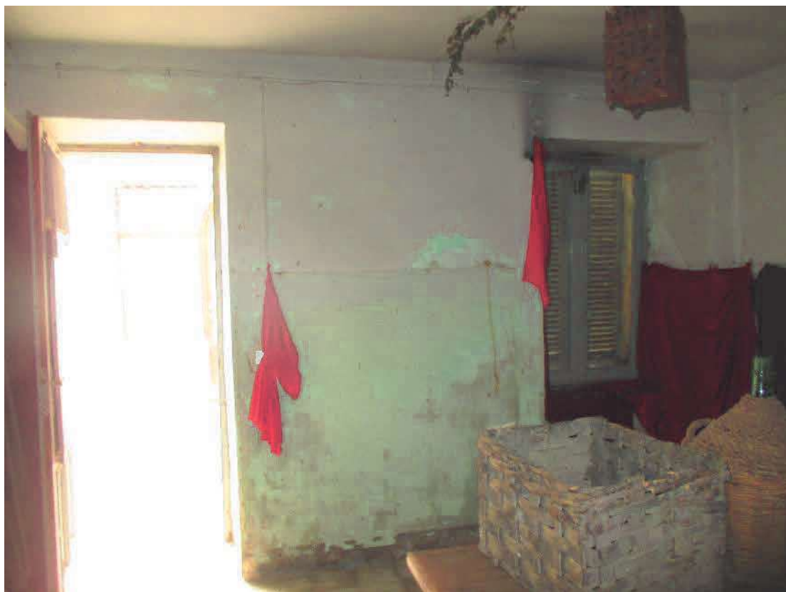
FOTO N. 9 – F. 9 MAPP. 377 SUB.1 – INGRESSO VIA FONTANA – LOTTO 1
