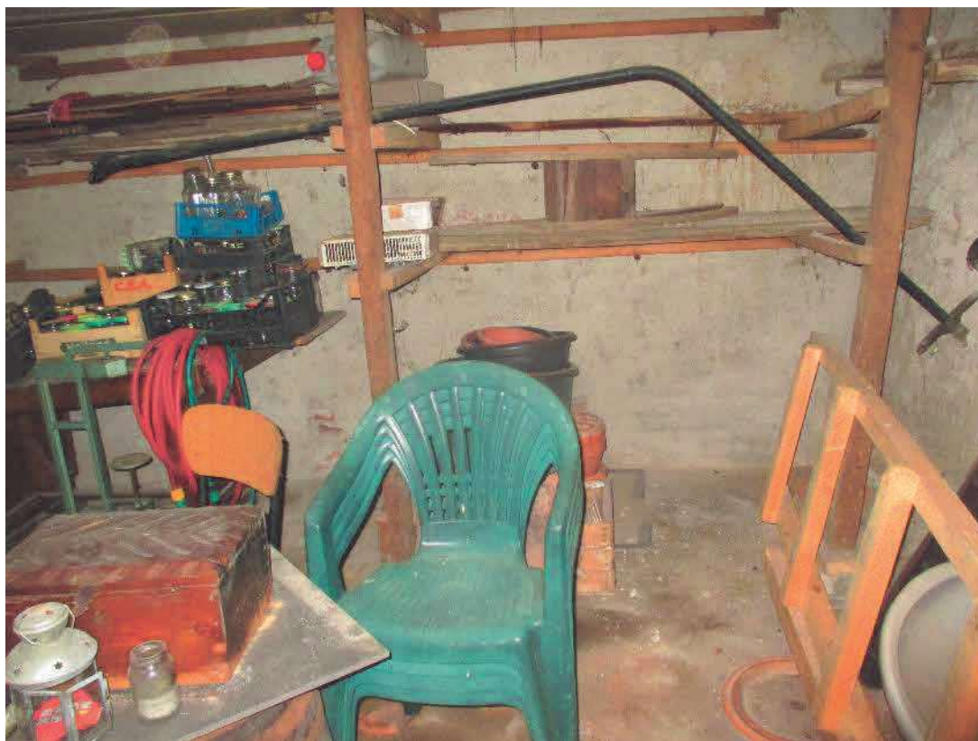
FOTO N. 15 – FOGLIO 9 MAPPALE 377 SUB.1 – CANTINA – LOTTO 1
