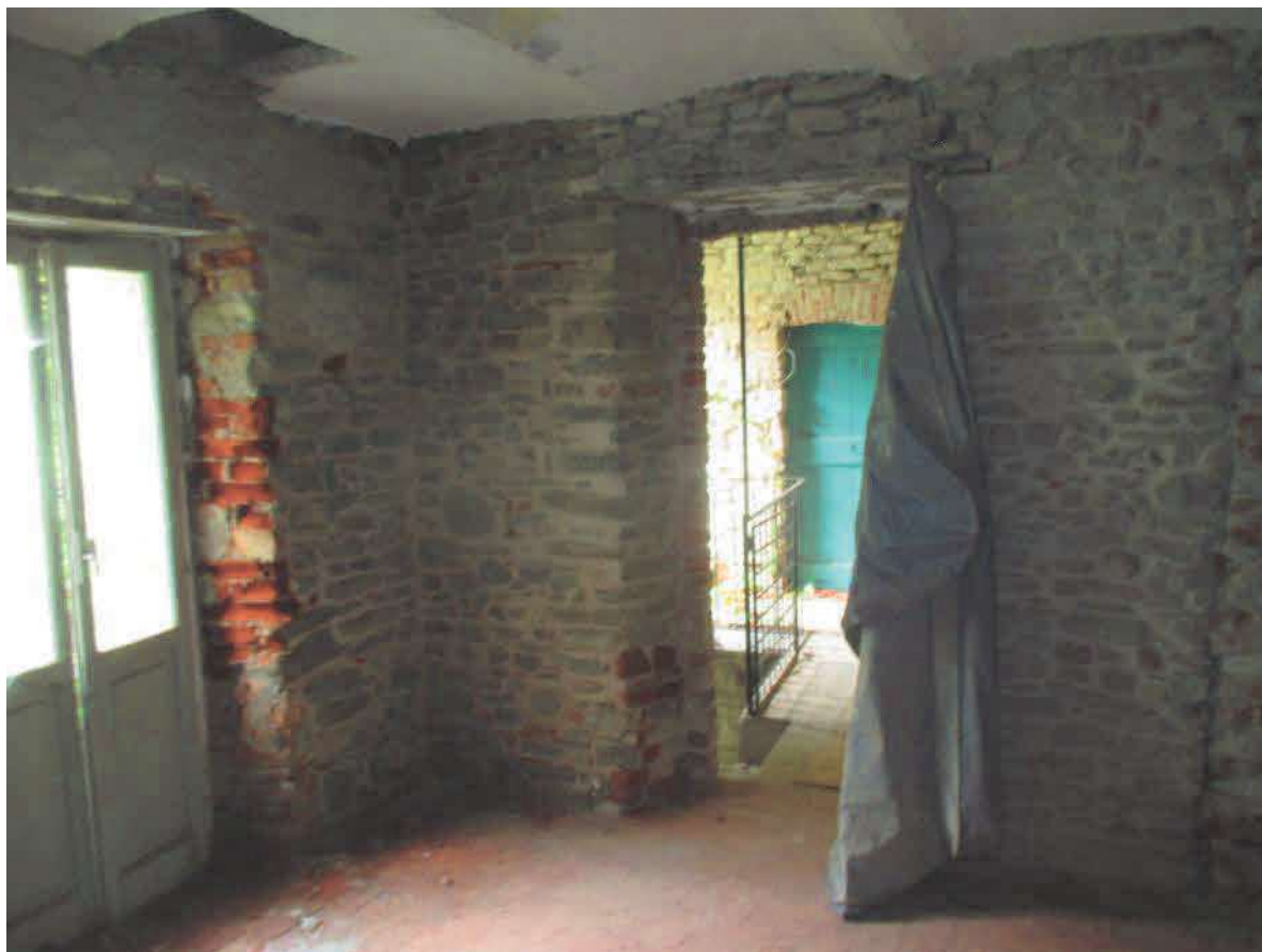
FOTO N. 24 – F. 9 MAPP. 377 SUB.1 – CAMERA A PIANO PRIMO – LOTTO 1
