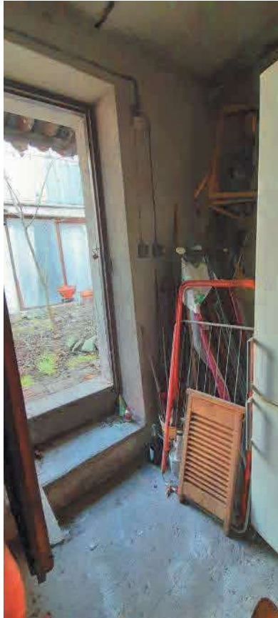
FOTO N. 45 – F. 9 MAPP. 490 SUB.4 – CANTINA A P. TERRA – LOTTO 2
