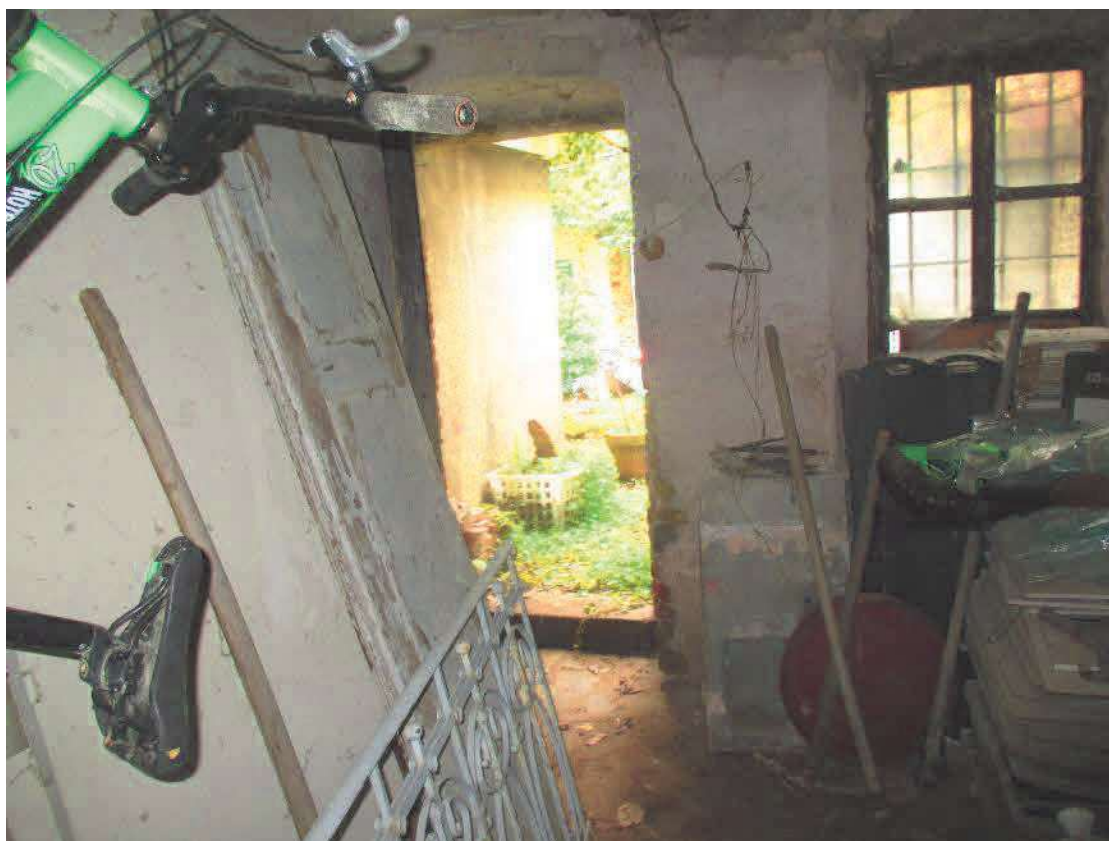
FOTO N. 16 – FOGLIO 9 MAPPALE 377 SUB.1 – LAVANDERIA – LOTTO 1
