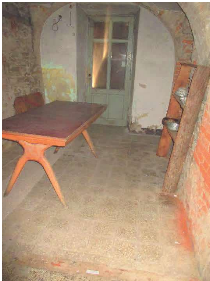
FOTO N. 13 – FOGLIO 9 MAPPALE 377 SUB.1 – RIPOSTIGLIO – LOTTO 1
