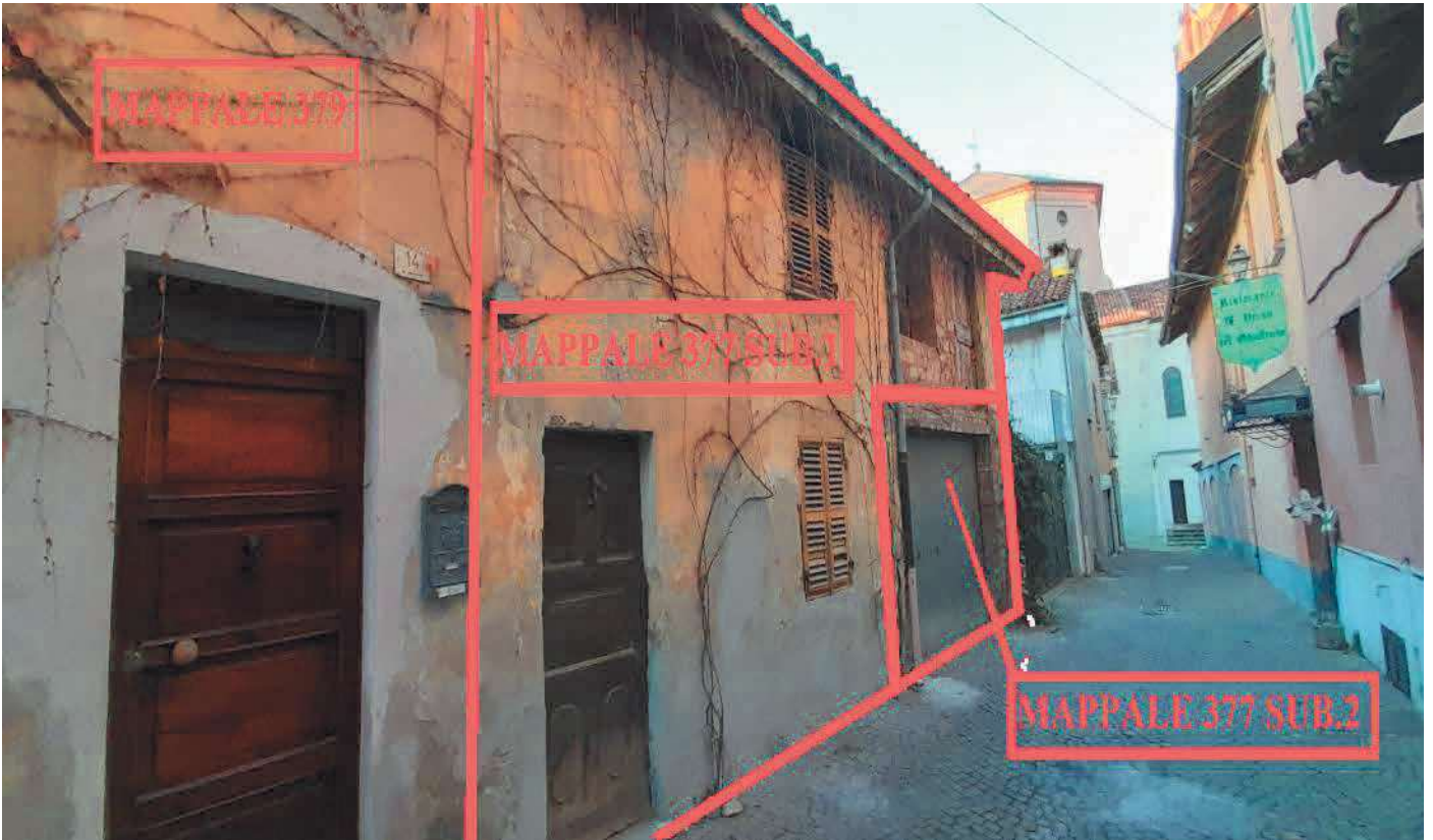
FOTO N. 5 – F. 9 MAPP.377 SUB.1 E 377 SUB.2 – VIA DEMAGISTRIS – LOTTO 1
