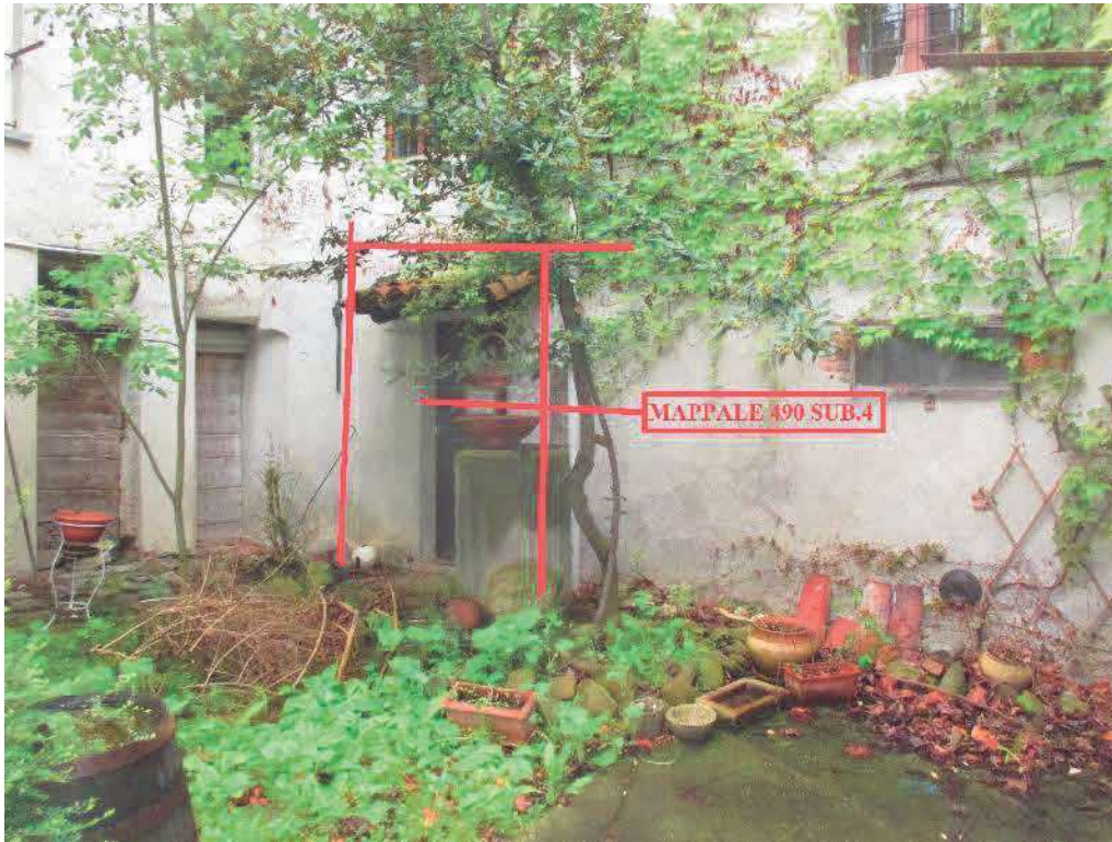
FOTO N. 43 – F. 9 MAPP. 490 SUB.4 – CANTINA A P. TERRA – LOTTO 2
