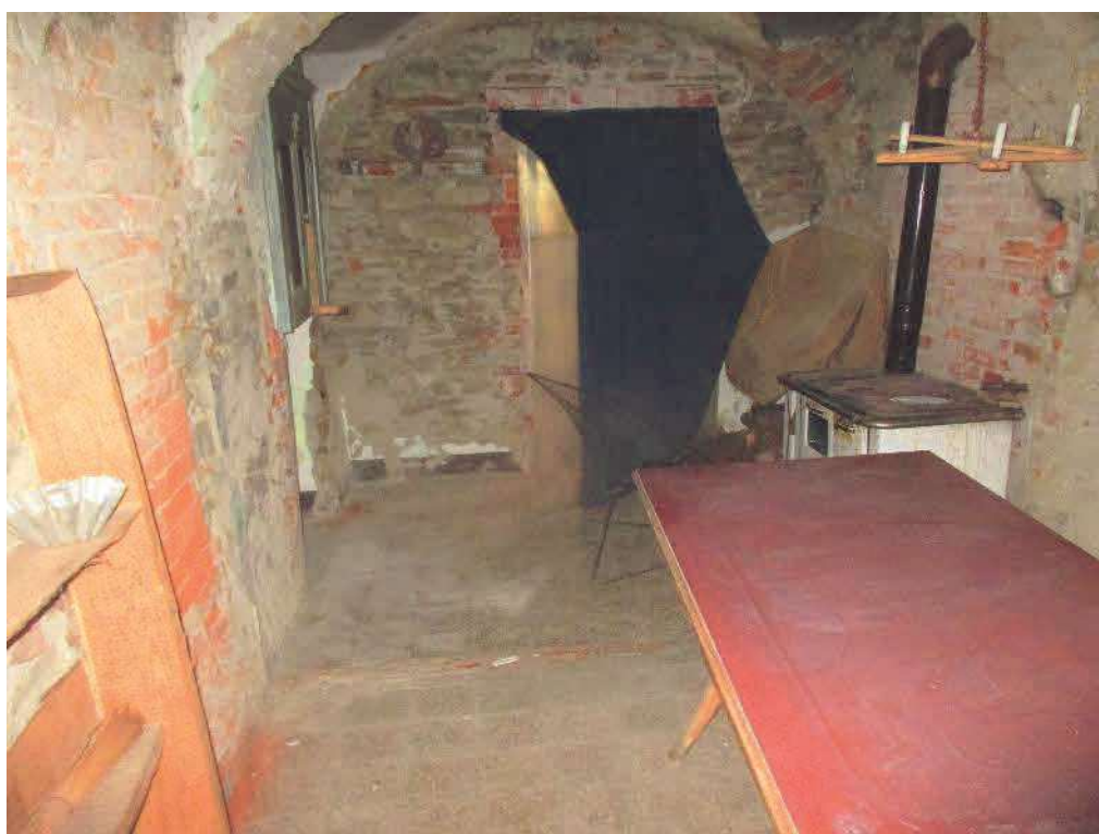
FOTO N. 12 – FOGLIO 9 MAPPALE 377 SUB.1 – RIPOSTIGLIO – LOTTO 1
