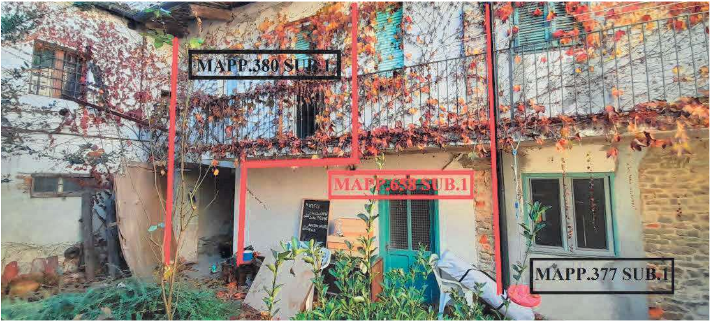
FOTO N. 35 – F. 9 MAPP. 380 SUB.1 – ABITAZ. – LATO CORTILE INT. – LOTTO 1
