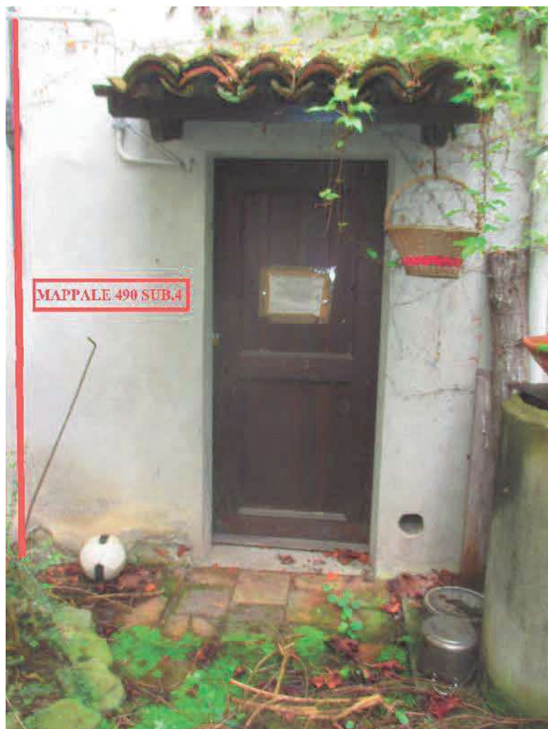
FOTO N. 42 – F. 9 MAPP. 490 SUB.4 – CANTINA A P. TERRA – LOTTO 2
