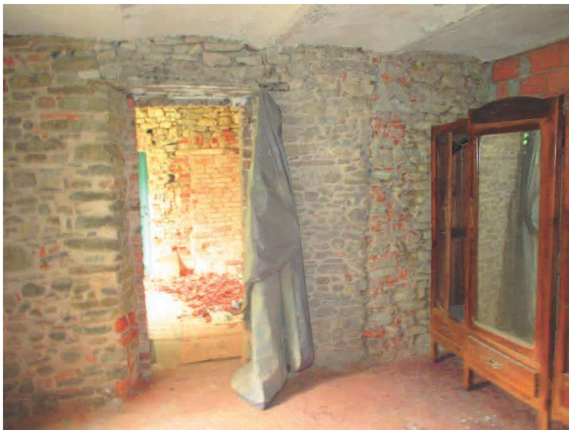
FOTO N. 25 – F. 9 MAPP. 377 SUB.1 – CAMERA A PIANO PRIMO – LOTTO 1
