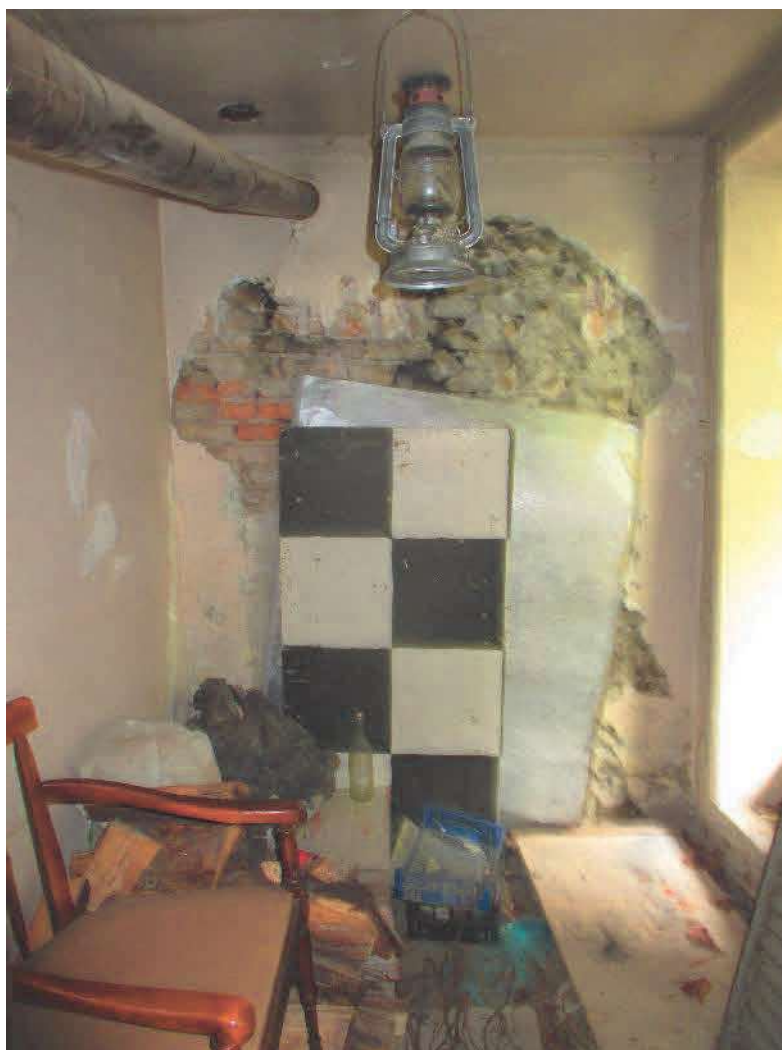
FOTO N. 11 – FOGLIO 9 MAPPALE 377 SUB.1 – CUCINA – LOTTO 1
