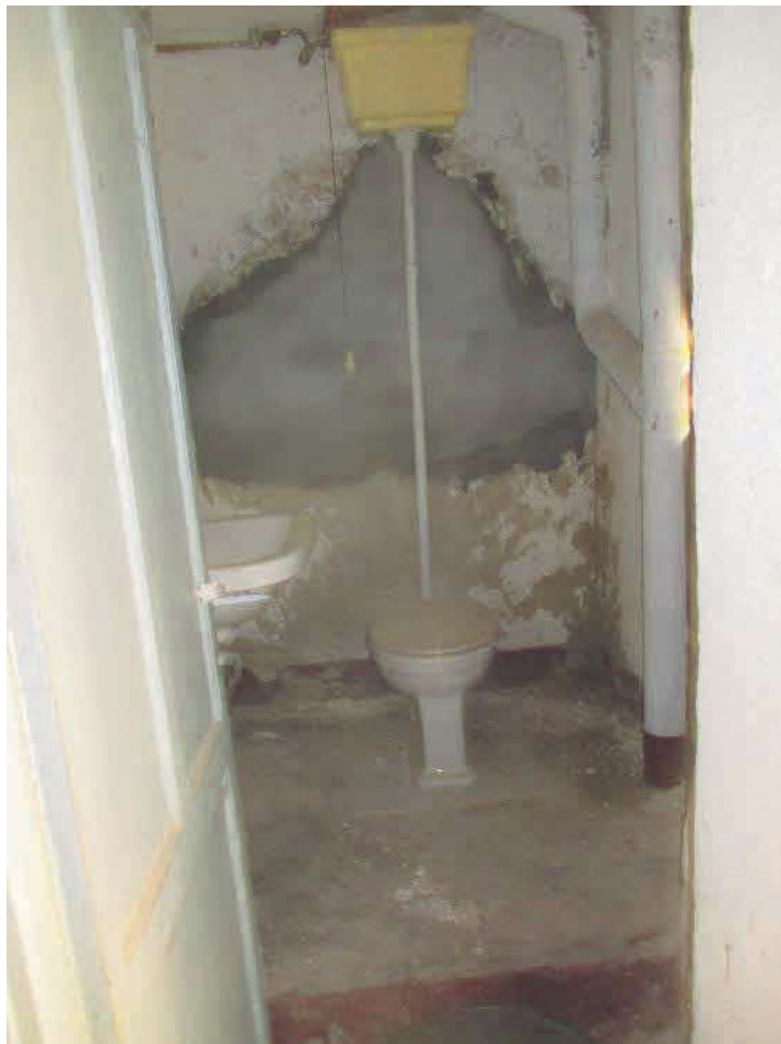
FOTO N. 18 – FOGLIO 9 MAPP. 377 SUB.1 – WC PIANO TERRA – LOTTO 1
