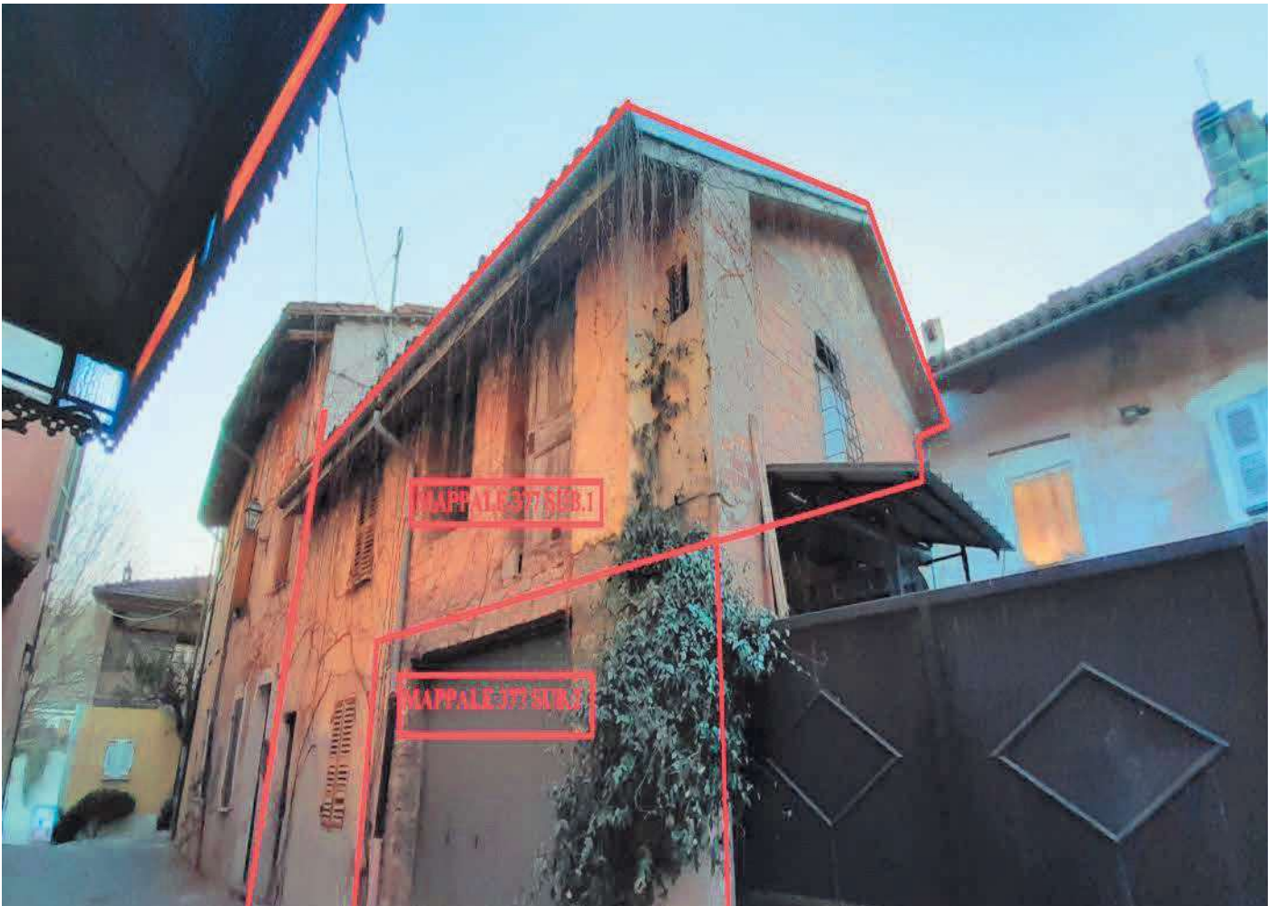
FOTO N. 6 – F. 9 MAPP.377 SUB.1 E 377 SUB.2 – VIA DEMAGISTRIS – LOTTO 1
