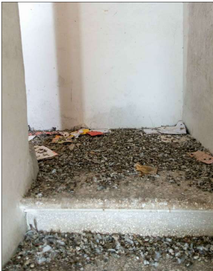
- Scale di accesso al Piano Secondo -
