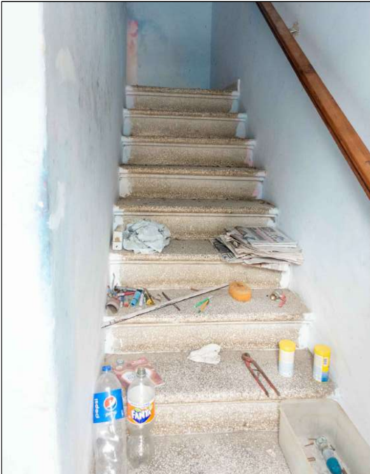
- Scale di Collegamento -
