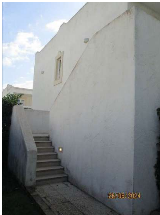
Foto n.3 – scala di accesso
