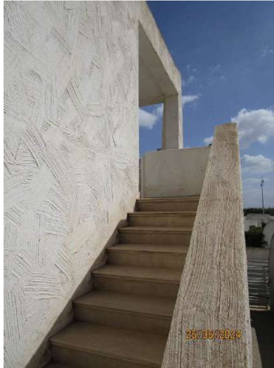
Scala di accesso all'appartamento
