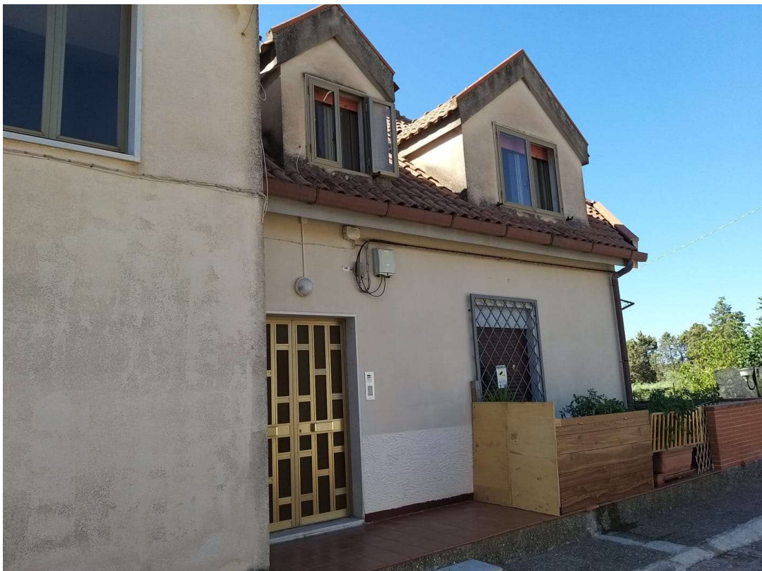
Foto 2 - Vista esterna del fabbricato in cui è ubicata l'unità immobiliare
