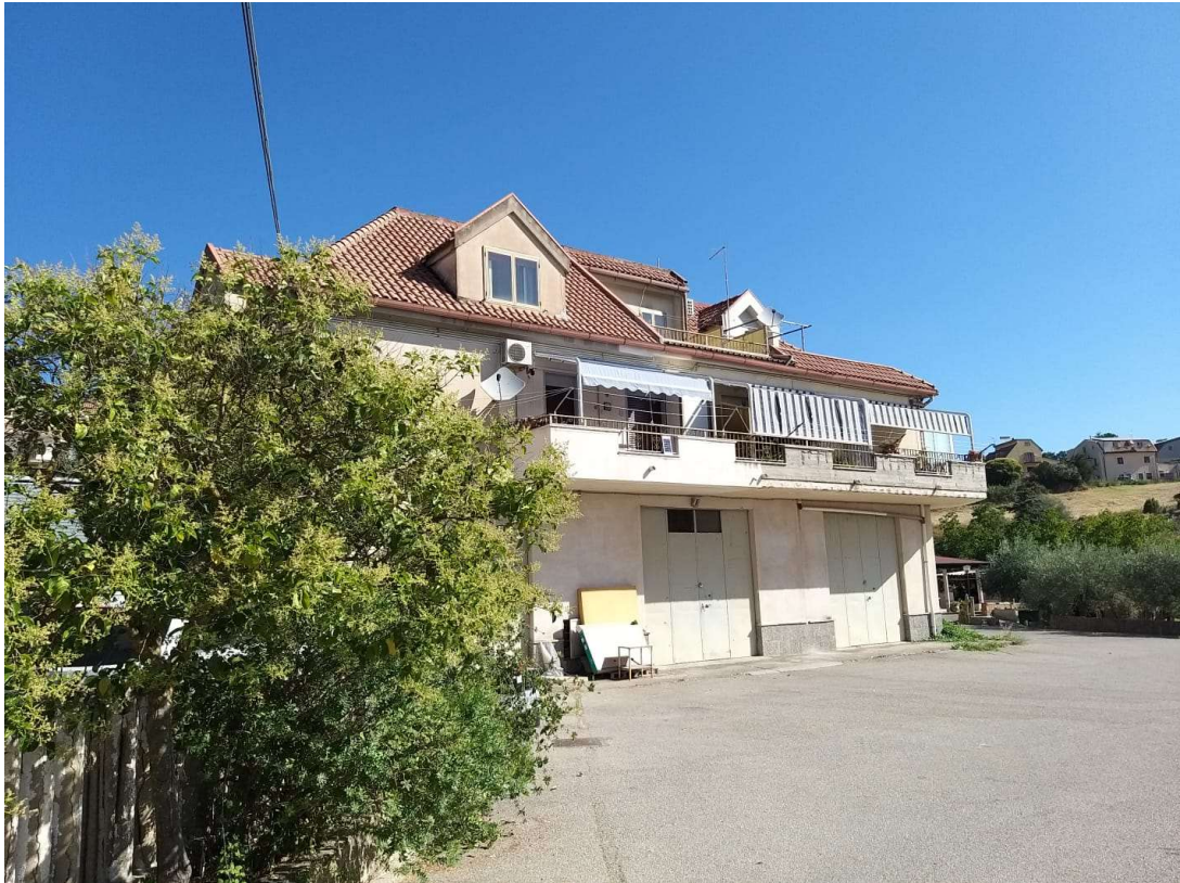
Foto 1 - Vista esterna del fabbricato in cui è ubicata l'unità immobiliare
