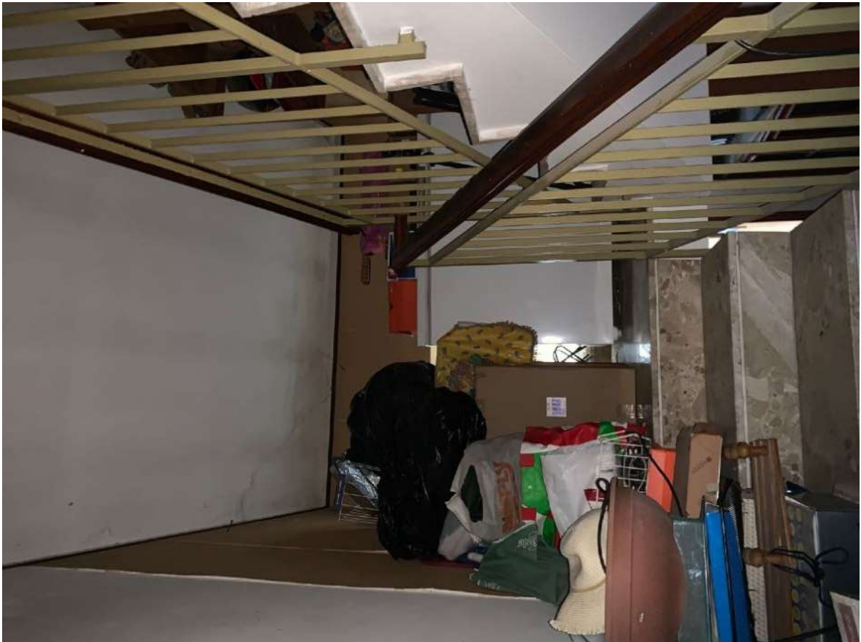
FOTO N. 33 – SCALA AL PIANO SOTTOTETTO
