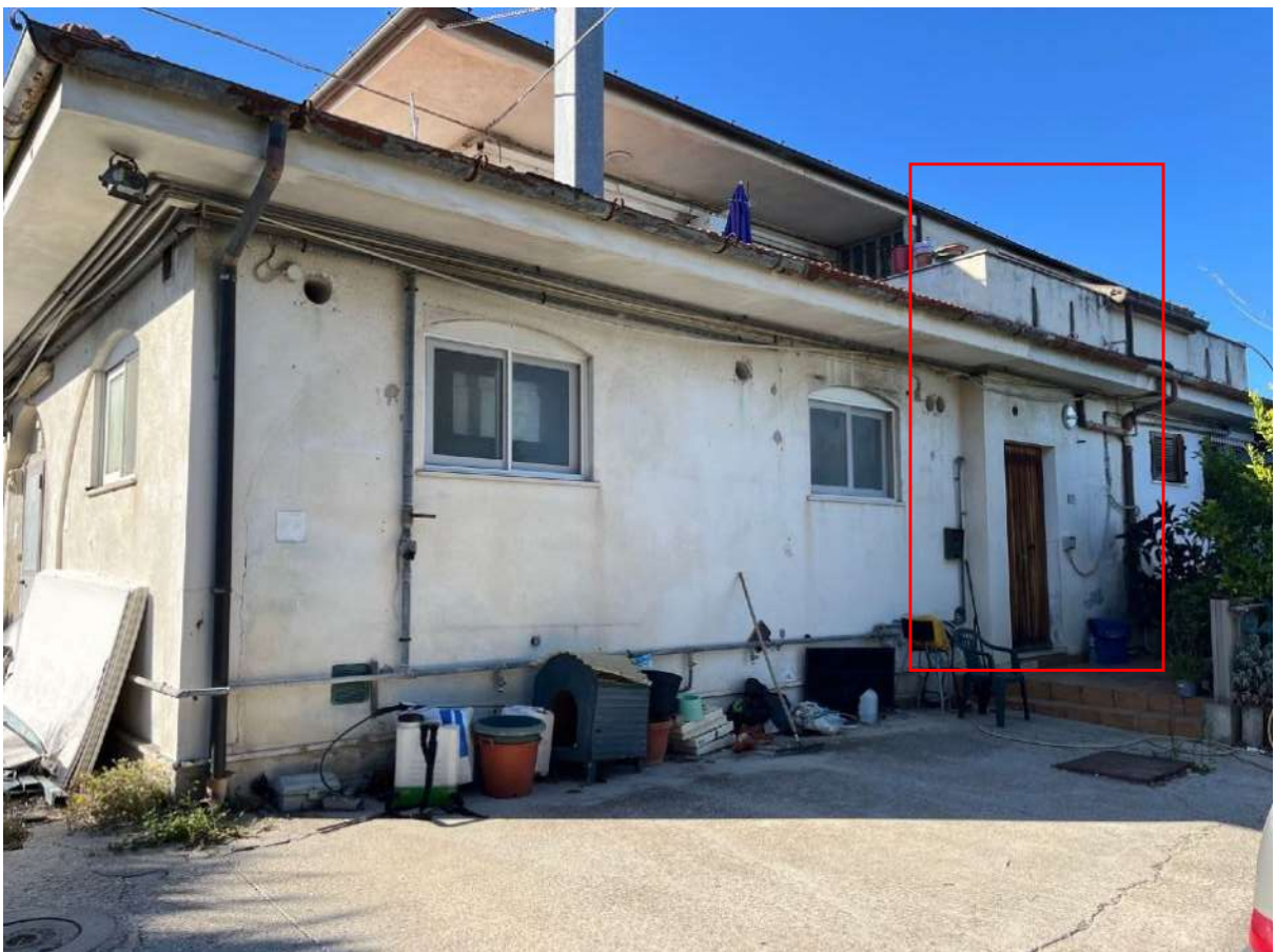
FOTO N. 4 – RETRO PROSPETTO – INGRESSO APPARTAMENTO
