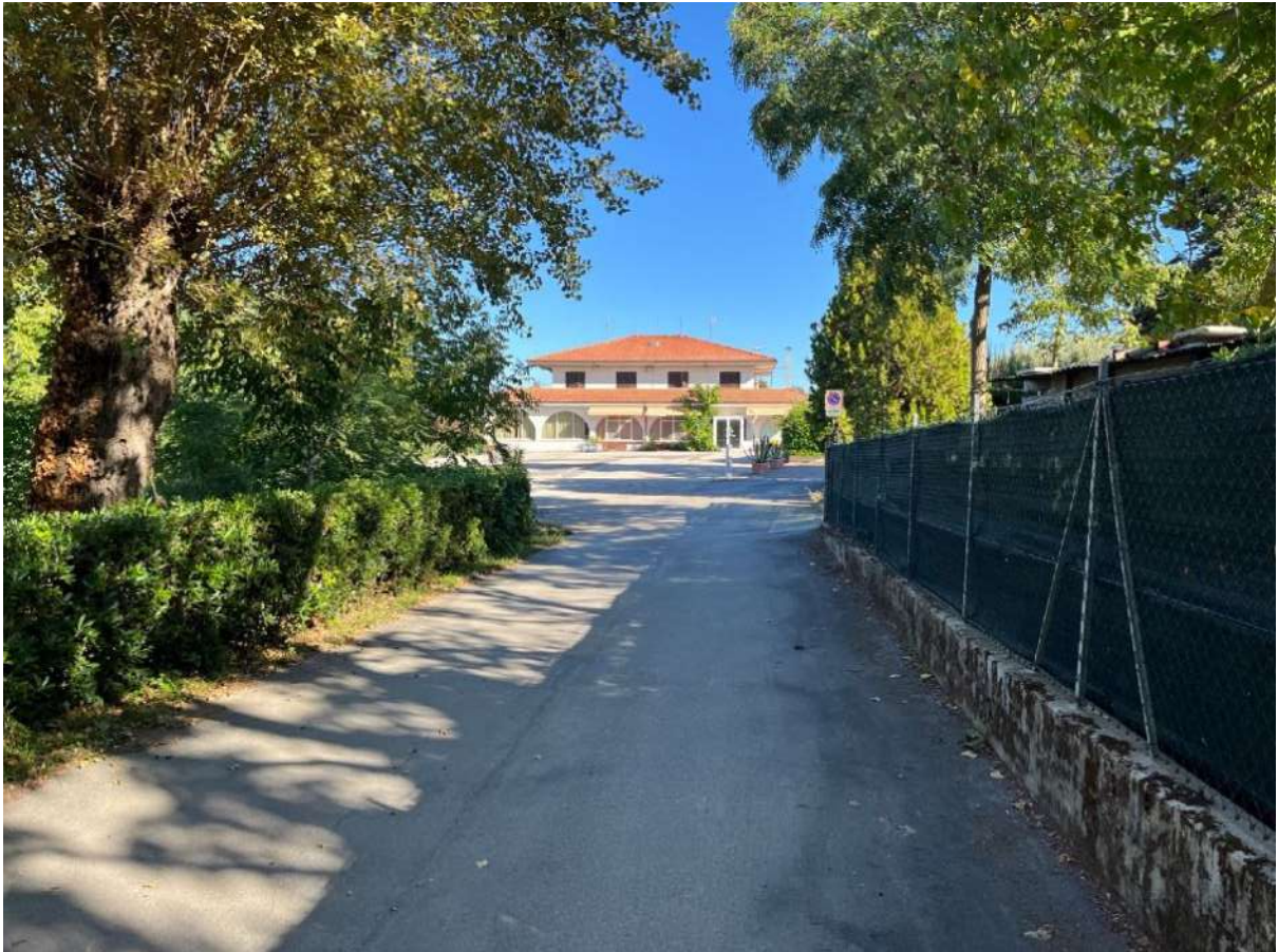
FOTO N. 1 – VISTA ACCESSO DA STRADA PRIVATA
