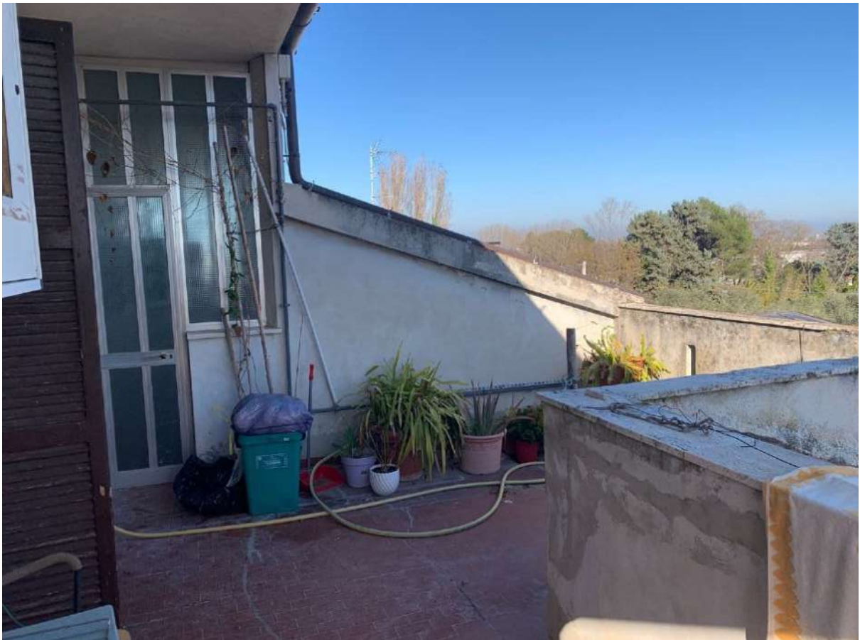
FOTO N. 32 – VISTA DAL TERRAZZO ARRIVO SCALA DAL P.T.
