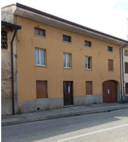
fronte principale - vista strada
