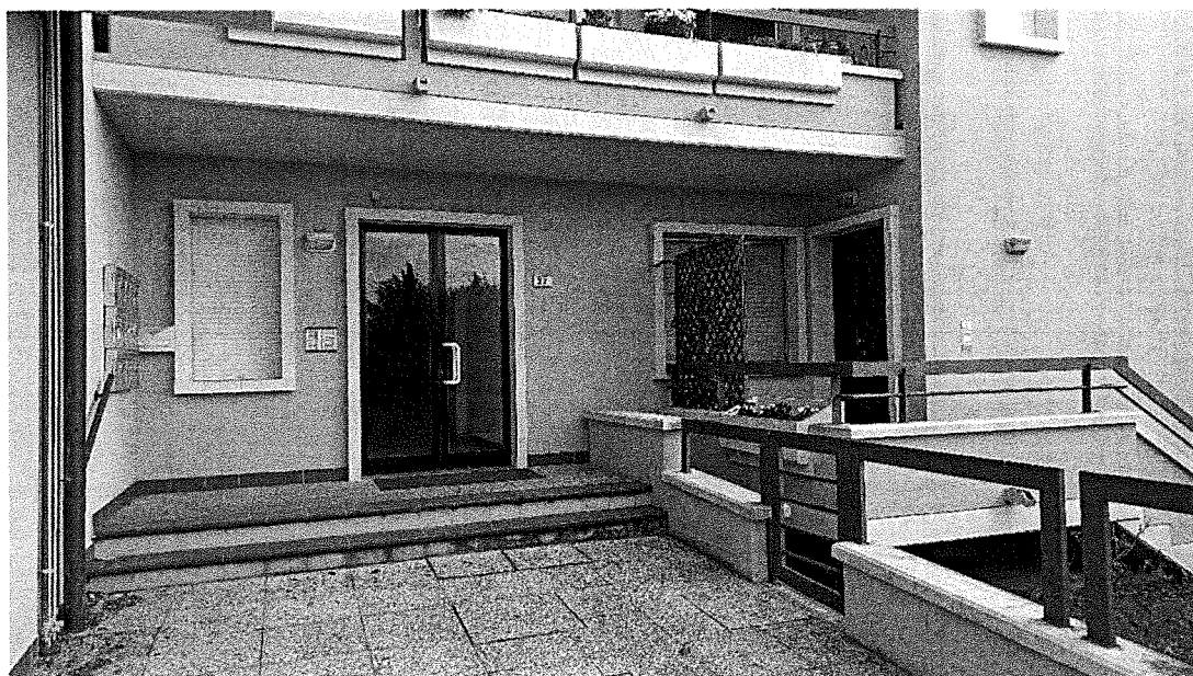
ACCESSO AL CONDOMINIO DAL CIVICO 22
