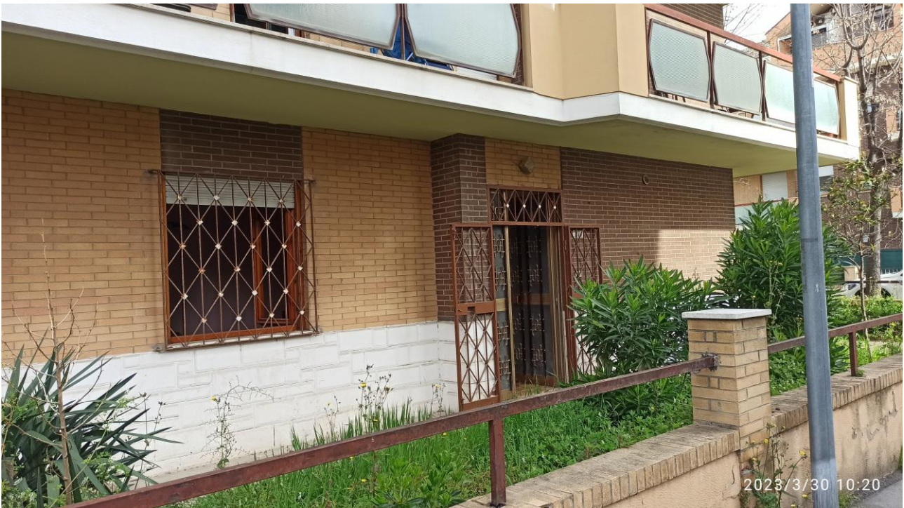
Foto n. 4 – Ingresso autonomo all'appartamento da via Monte Velino
