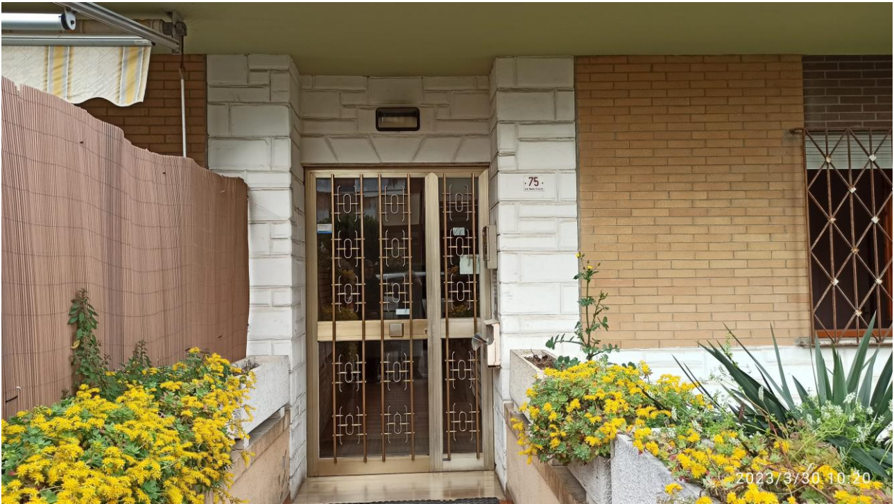
Foto n. 3 – Ingresso al fabbricato da via Monte Velino
