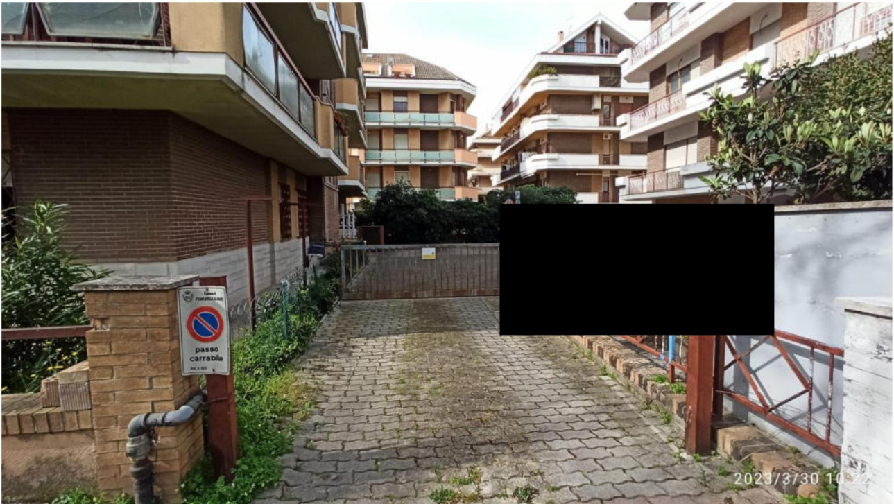
Foto n. 18 – Accesso al parcheggio condominiale da via Monte Sirente
