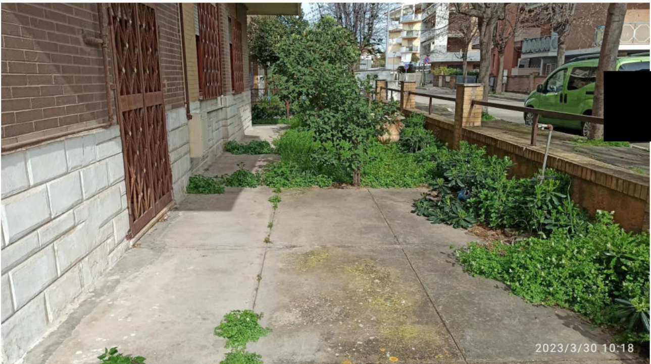
Foto n. 15 – Corte prospiciente via Monte Sirente
