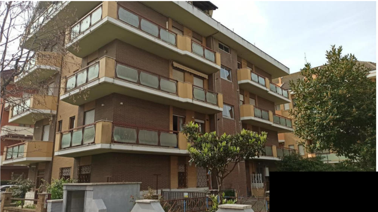
Foto n. 2 – Fabbricato visto da via Monte Velino
