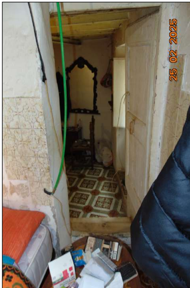
Figura 8 – Ingresso camera p.terra - bene n.1
