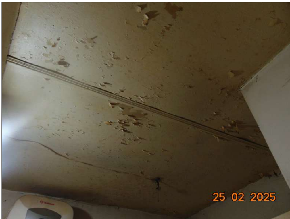
Figura 21 – Dettaglio controsoffitto e scaldacqua elettrico bagno – bene n.1
