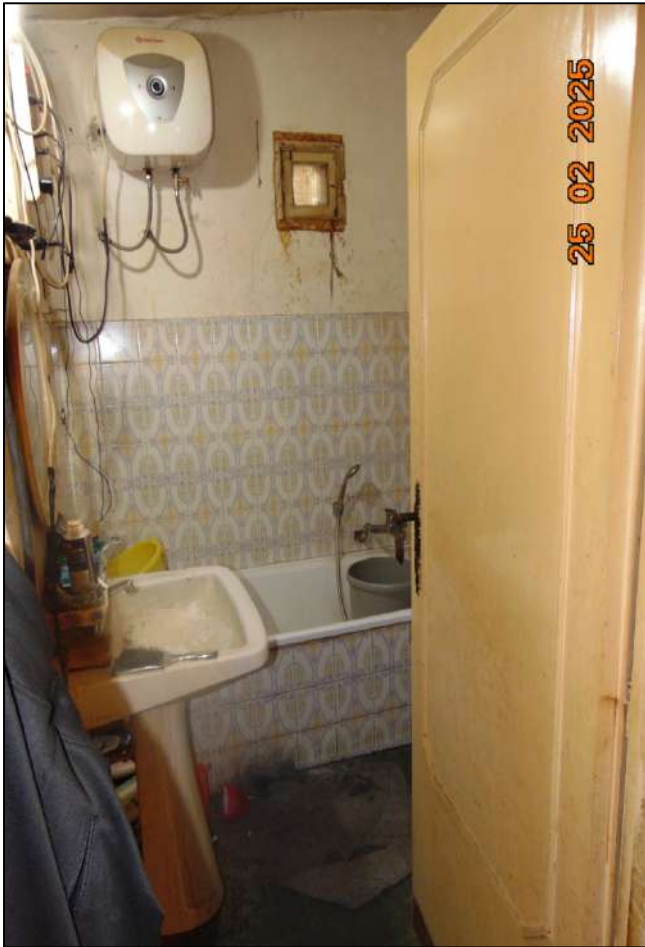
Figura 17 – Bagno piano primo – bene n.1
