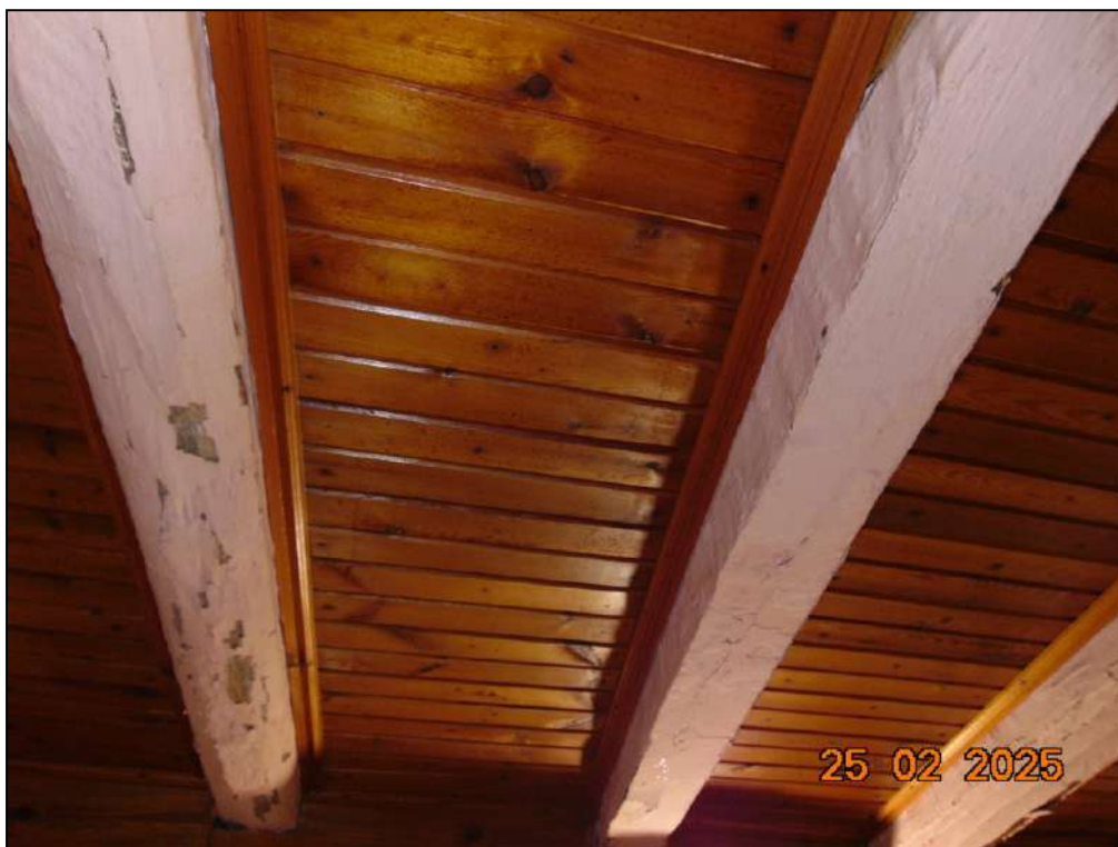
Figura 11- Visuale di dettaglio solaio tra piano terra e piano primo
