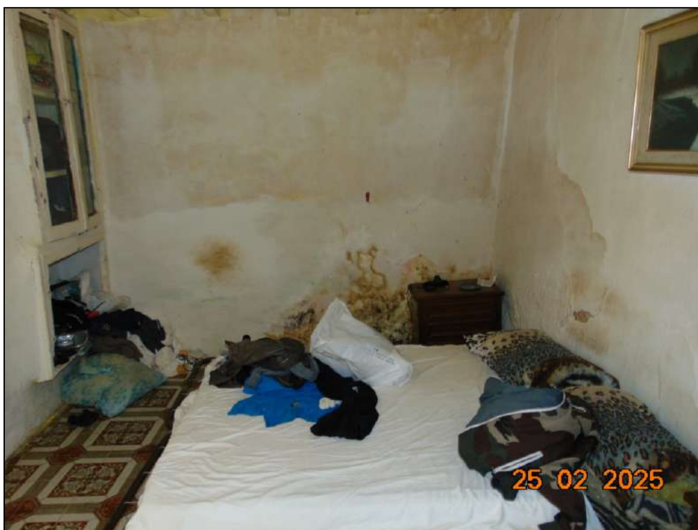
Figura 12- Visuale interna camera da letto piano terra – bene n.1
