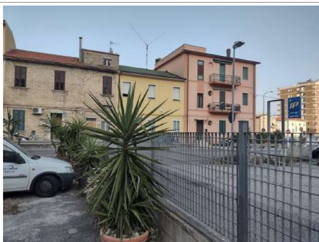
Part. Recinzione sud corte esterna
