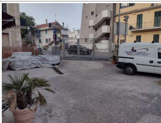
Corte esterna comune p.terra e primo
