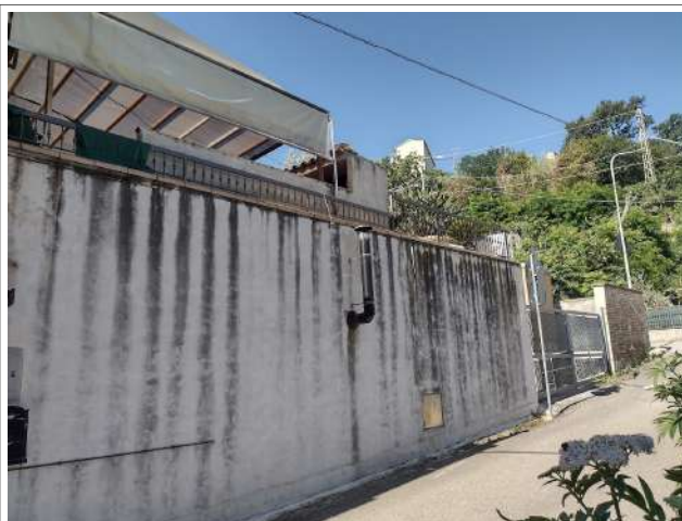
Particolare muro zona ovest prospetto via Madonna degli Angeli
