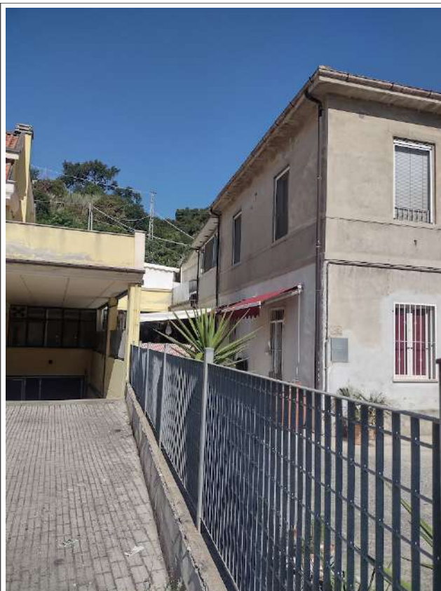
Part. Corte cintata lato sud
