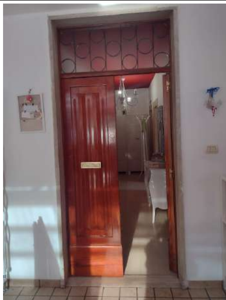
Ingresso zona p1 - sub 8 fabbricato in origine zona notte
