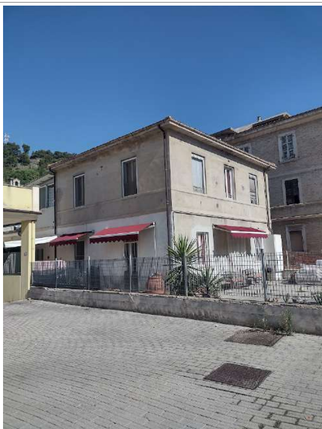
Fabbricato esecutato vista sud/est e corte cintata lato sud
