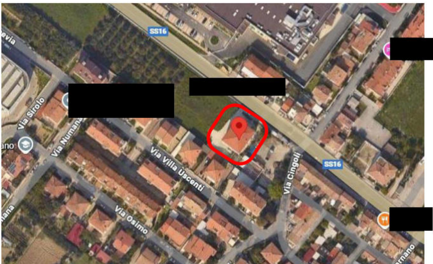
Foto 3 – Ingrandimento dell'immagine precedente con vista dall'alto del fabbricato oggetto di perizia, in loc. Baia Metauro, in adiacenza alla S.S. Adriatica 16 che collega Fano ad Ancona (sempre da Google maps).
