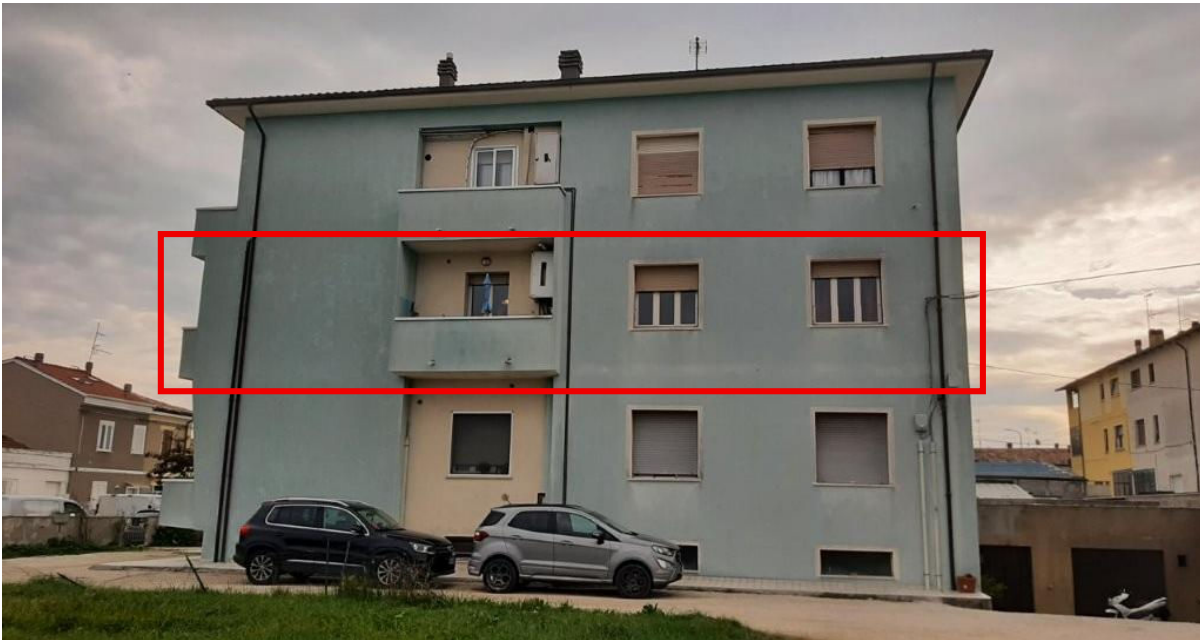
Foto 7 – Vista del fianco Dx con punto di scatto dallo scoperto a verde adiacente con accesso carrabile ai locali accessori sul retro.
