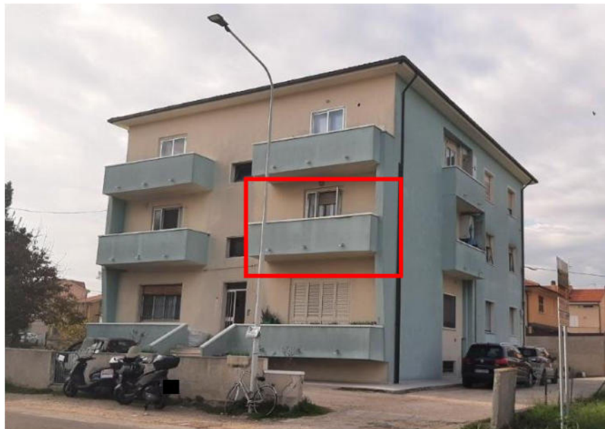
Foto 5 e 6 – N. 2 viste del prospetto fronte (lato strada e ingresso) del fabbricato condominiale al civico 86, con punti di scatto dall'antistante Strada Statale Adriatica 16 ed indicazione della porzione occupata dall'unità abitativa oggetto di procedura espropriativa.
