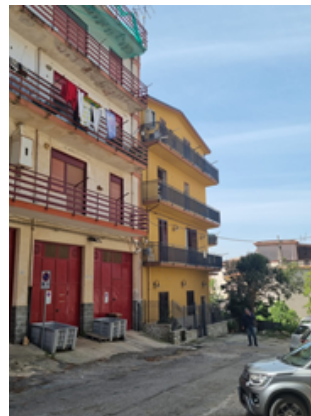
prospetto su via L.Pirandello
