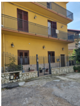
prospetto su via L.Pirandello
