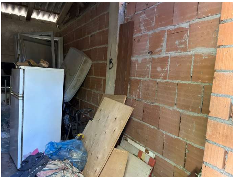
Foto 3: interno locale sgombero
