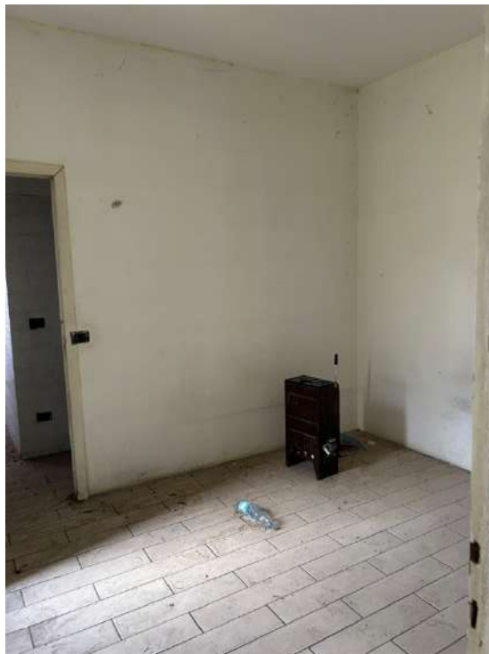
Foto 8: seconda stanza e passaggio verso disimpegno del bagno
