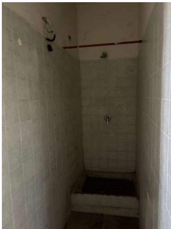
Foto 9: nel disimpegno bagno è stata ricavata la doccia
