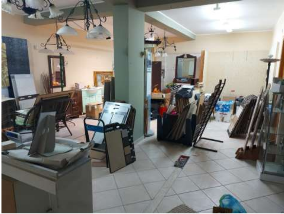
Particolare della pavimentazione : listelli in marmo per coprire le aree che occupavano i tramezzi
