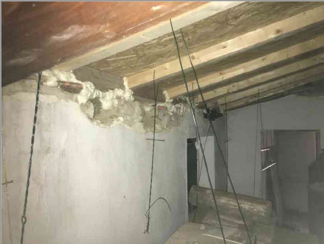
TAMPONAMENT O TETTO P1
