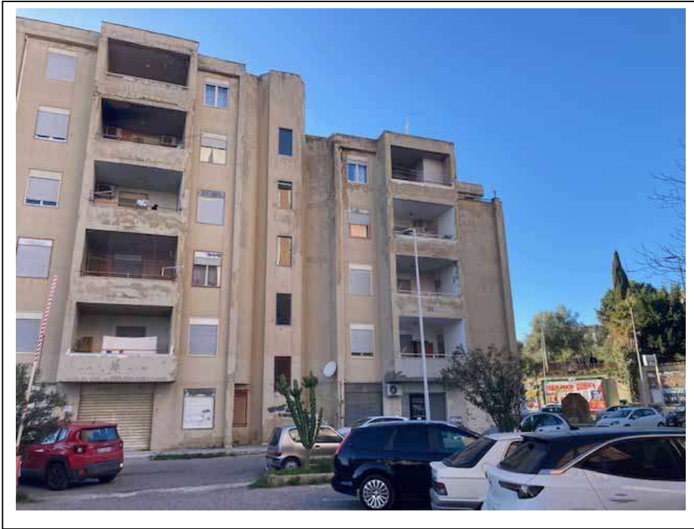
Fotografia n. 1 – Esterno Civico N. 169 - Scala D
