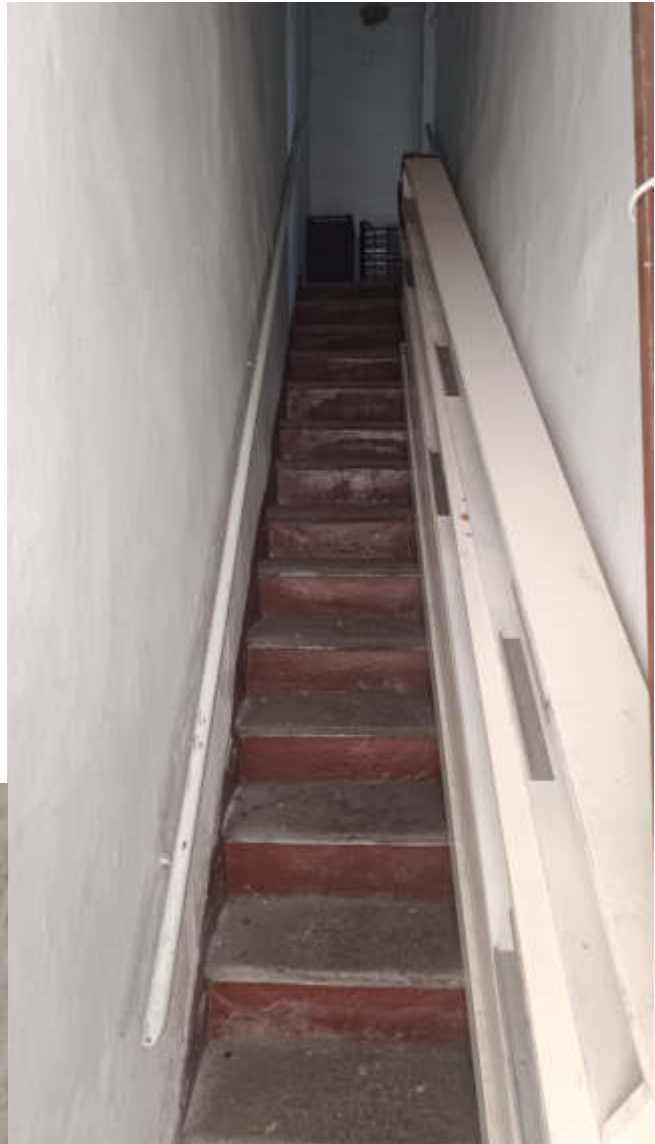
20: VISTA INTERNA SCALA DI ACCESSO ALLE UNITA' (BENE COMUNE) DA PIANO TERRENO
