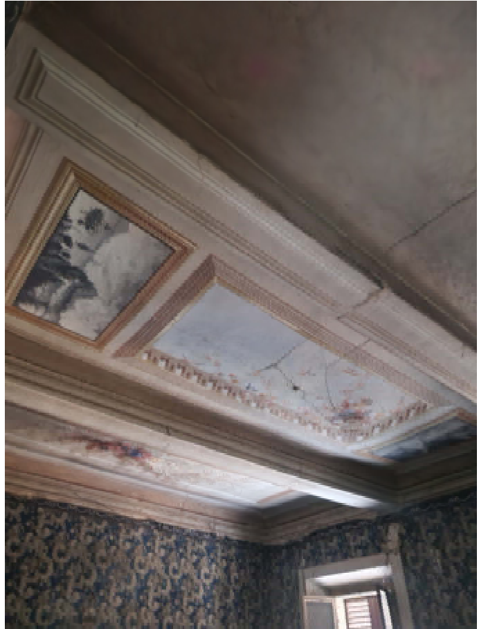
10: SUB 14 DETTAGLIO SOFFITTO VANO SOGGIORNO
