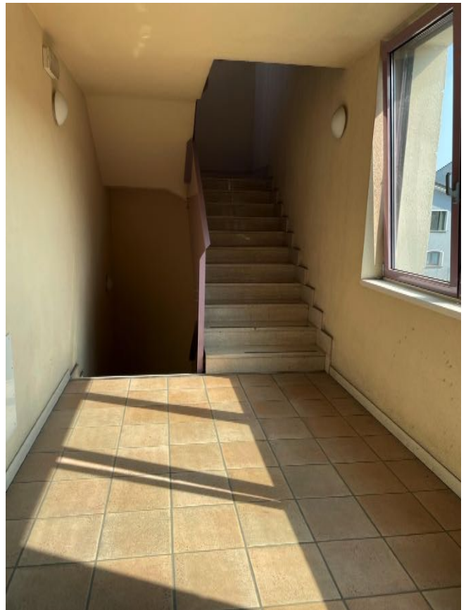
Vano scale - disimpegno comune (primo piano)
