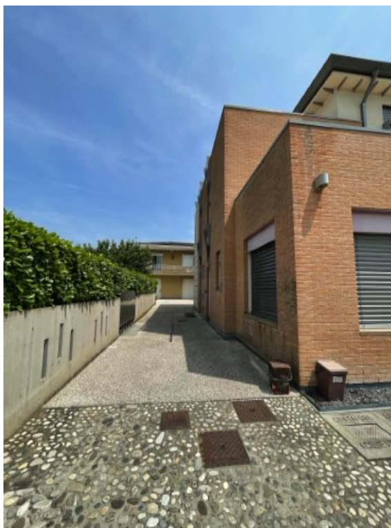
Scorcio prospetto Nord dell'edificio - area scoperta comune
