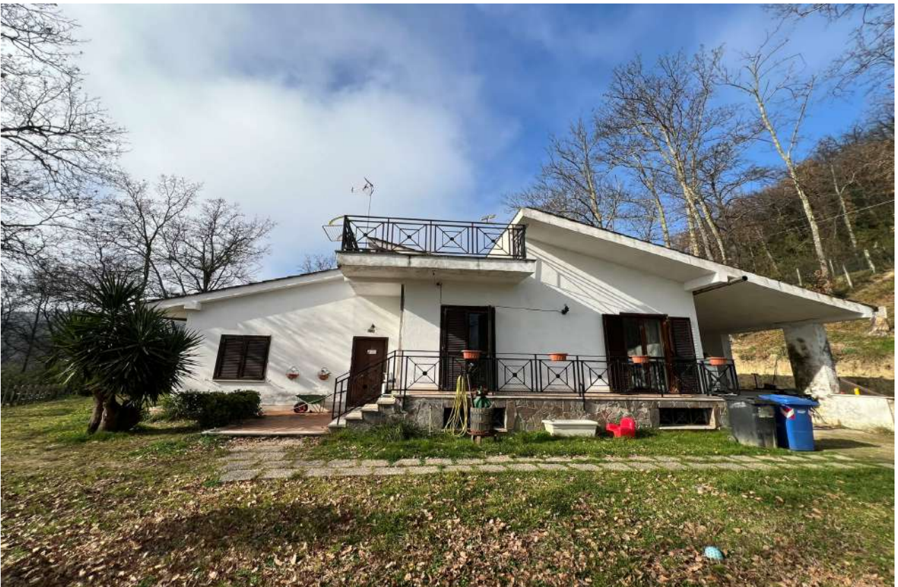
FOTO 2: Veduta esterna prospettiva nord-est
