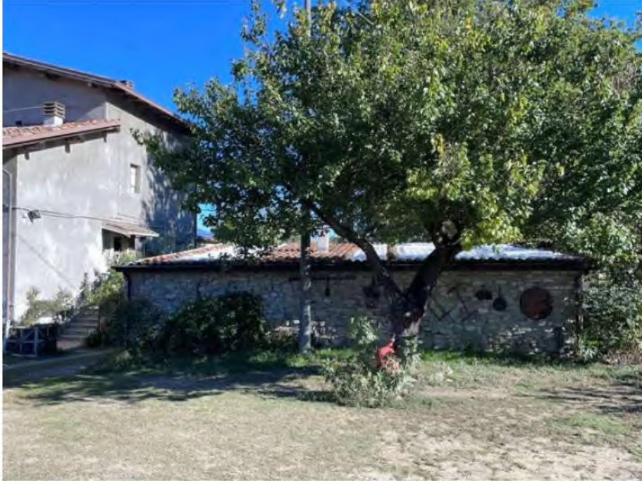
Fot. N. 27: Deposito (lato sud)
