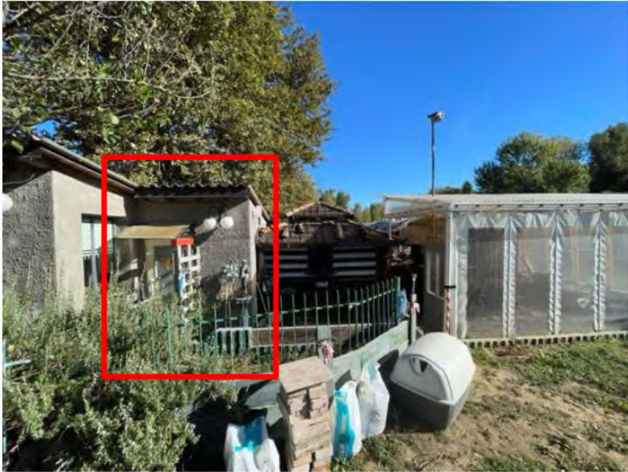
Fot. N. 30: Servizi igienici (ingresso - vista lato sud) realizzata su partt. 60 e 375
