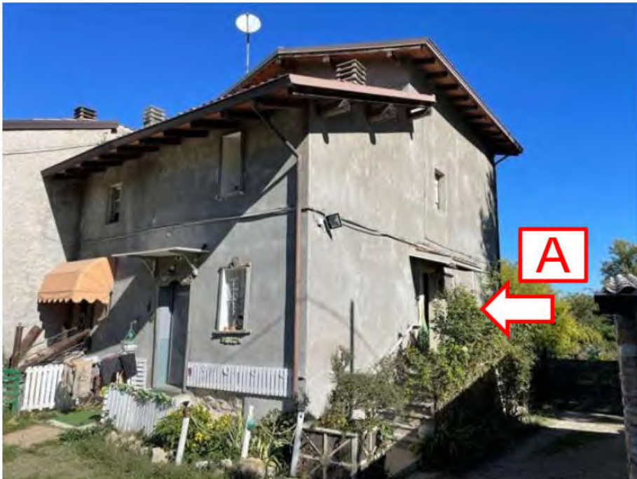
Fot. N. 4: Vista lati Sud/Est
