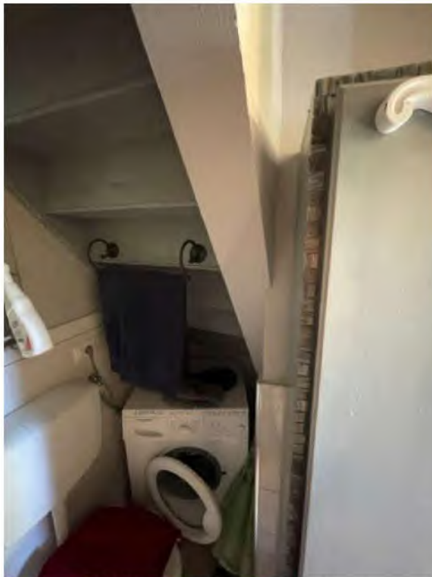
Fot. N. 14: Unità B – Bagno p.rialzato
