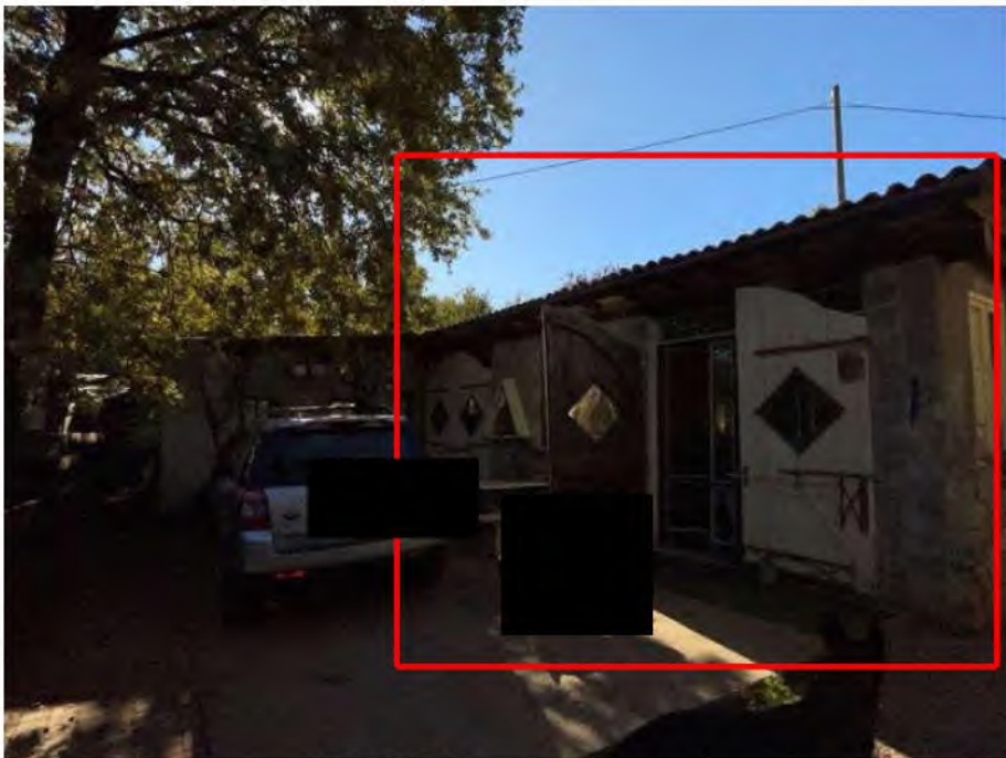
Fot. N. 28: Deposito (lato nord)
