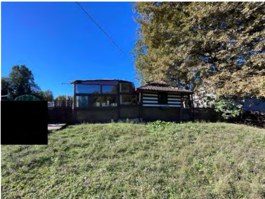
Fot. N. 31: Costruzioni precarie non autorizzate ad uso agriturismo realizzate su part. 375
