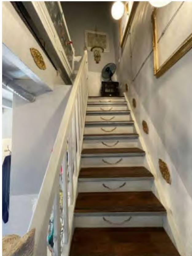
Fot. N. 16: Unità B – Scala di collegamento
