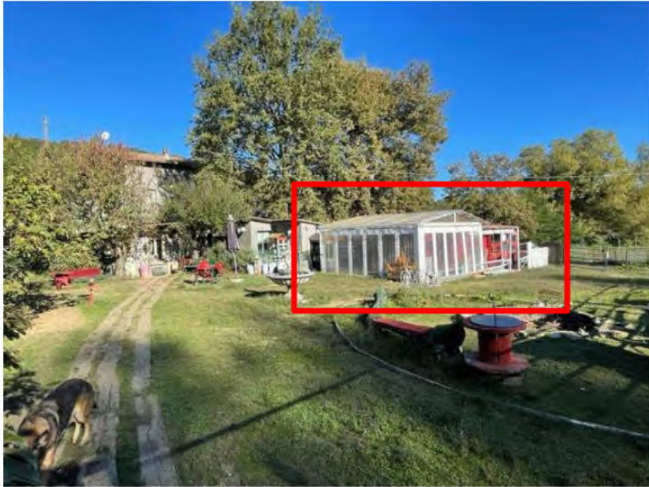
Fot. N. 34: Costruzione precaria non autorizzata ad uso agriturismo, destinata all'ospitalità, realizzata su partt. 60 e 375
