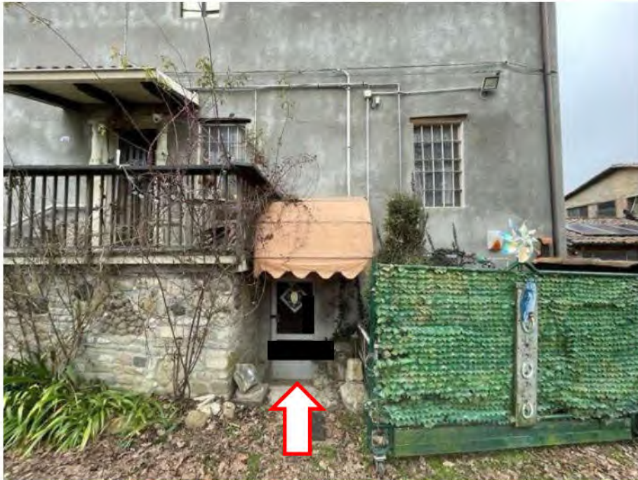
Fot. N. 17: Ingresso cantina (grande)
