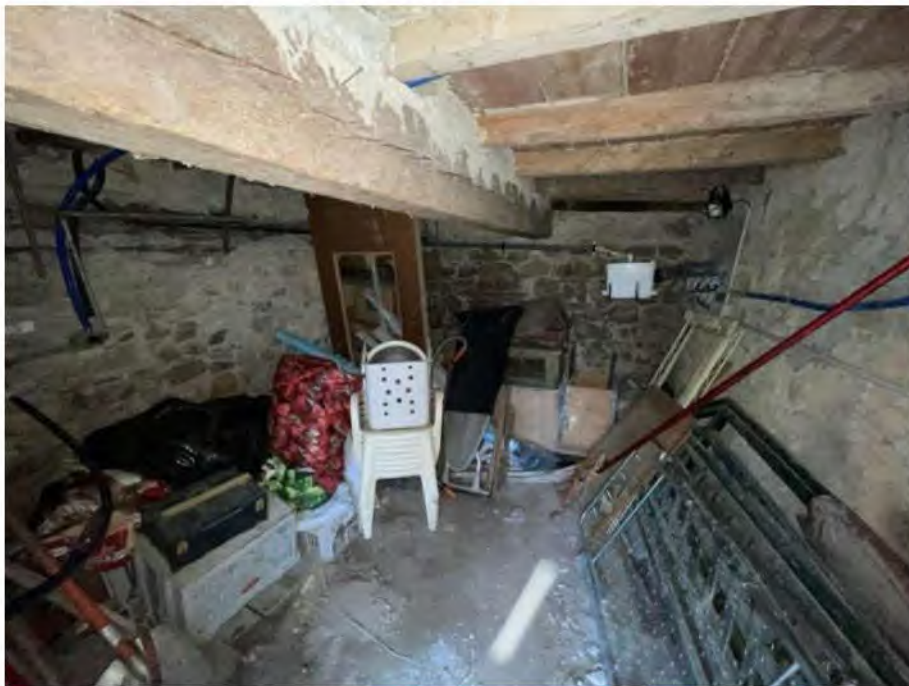
Fot. N. 22: Interno cantina (piccola) – lato sud
