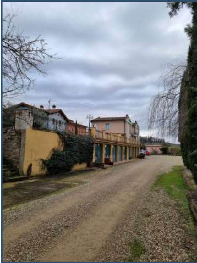
FOTO 8 EDIFICIO DEI GARAGE
