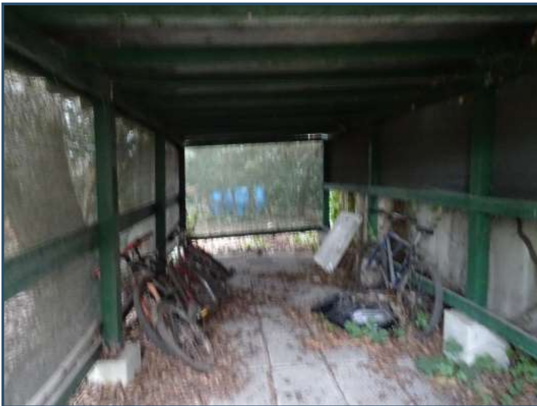
FOTO 12 TETTOIA ADIACENTE INGRESSO PEDONALE
