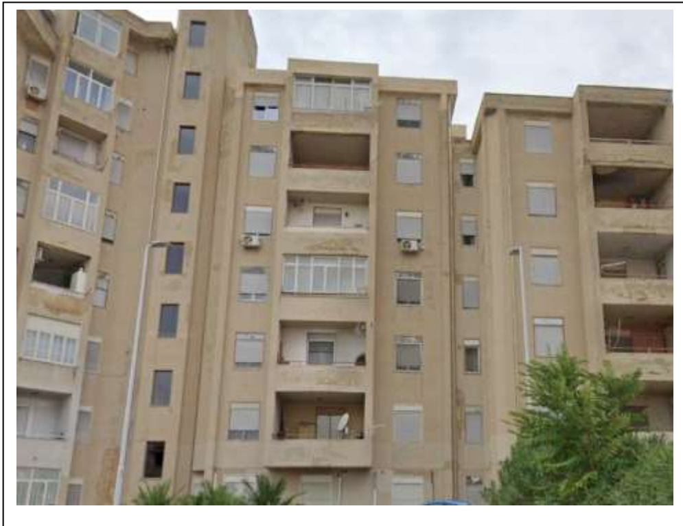
Fotografia n. 2 – Esterno Civico N. 179 - Scala C
