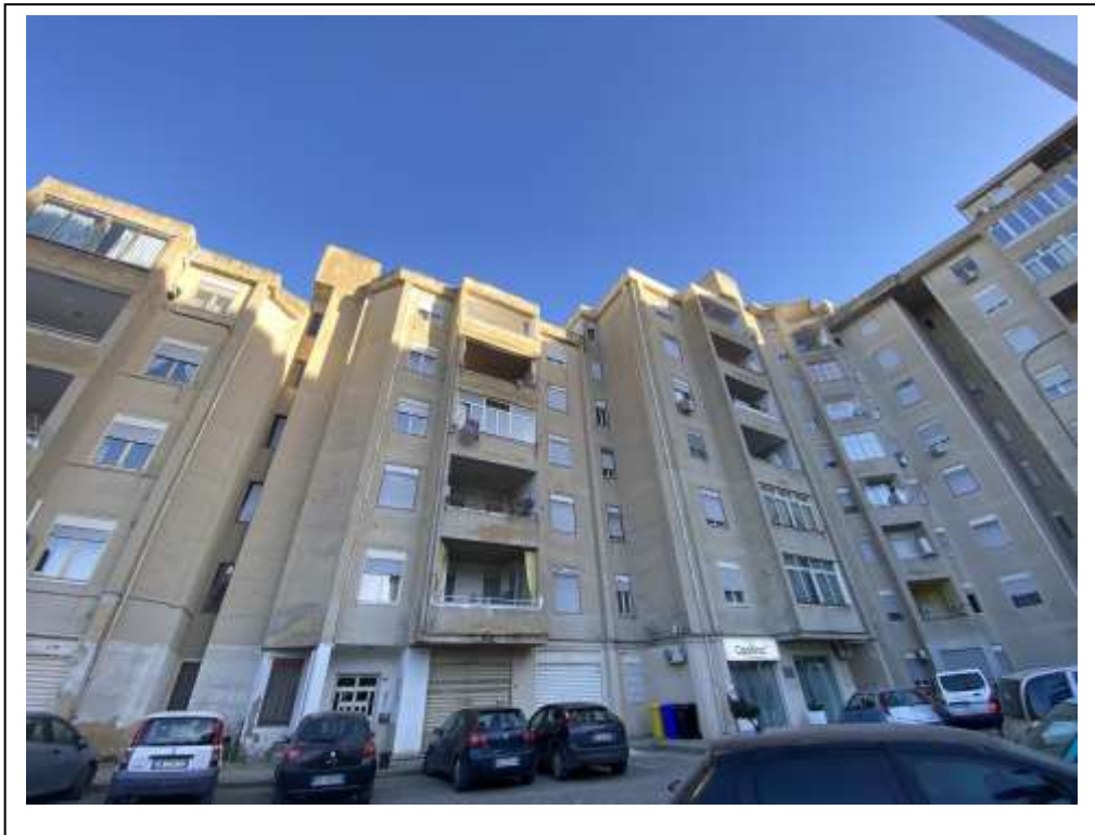
Fotografia n. 1 – Esterno Civico N. 179 - Scala C
