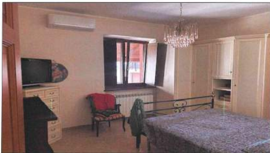
Foto n° 14 – Vista interna salone (pranzo) sono visibili impianto di raffrescamento e di riscaldamento tramite split e termosifoni.
