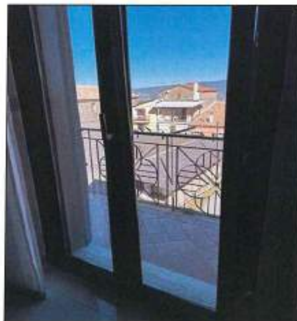
Foto n° 40 – Vista particolare infisso esterno (interno) con apertura a vista.
