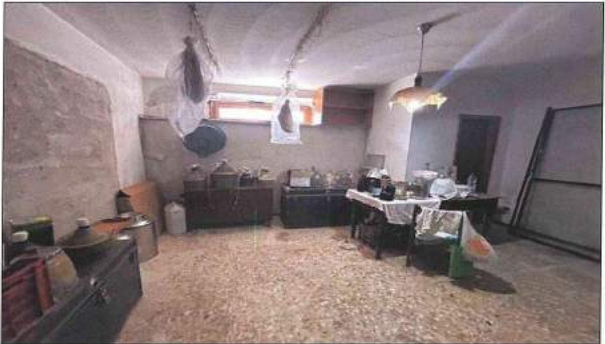
Foto n° 52 –Vista interna locale macchine ed impianti.
