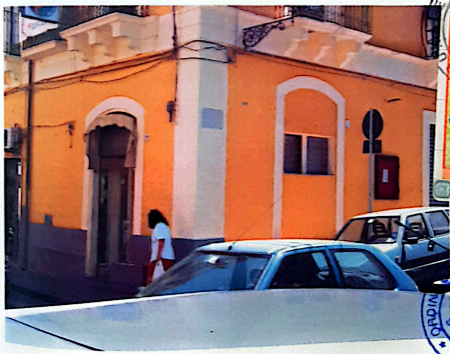
Foto n. 10: Lentini, foglio 91, particella 8098, sub 3, veduta esterna da via Garibaldi.
