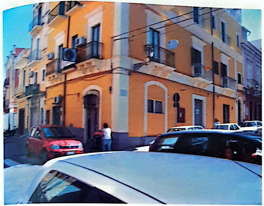
Foto n. 9: Lentini, foglio 91, particella 8098, sub 3, veduta esterna da via Garibaldi.
