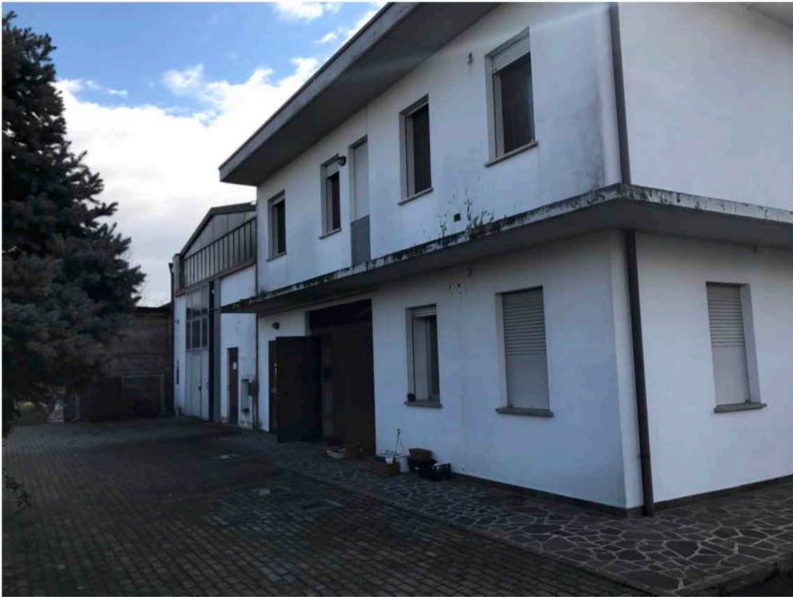
4 - Vista lato nord zona uffici/abitazione
