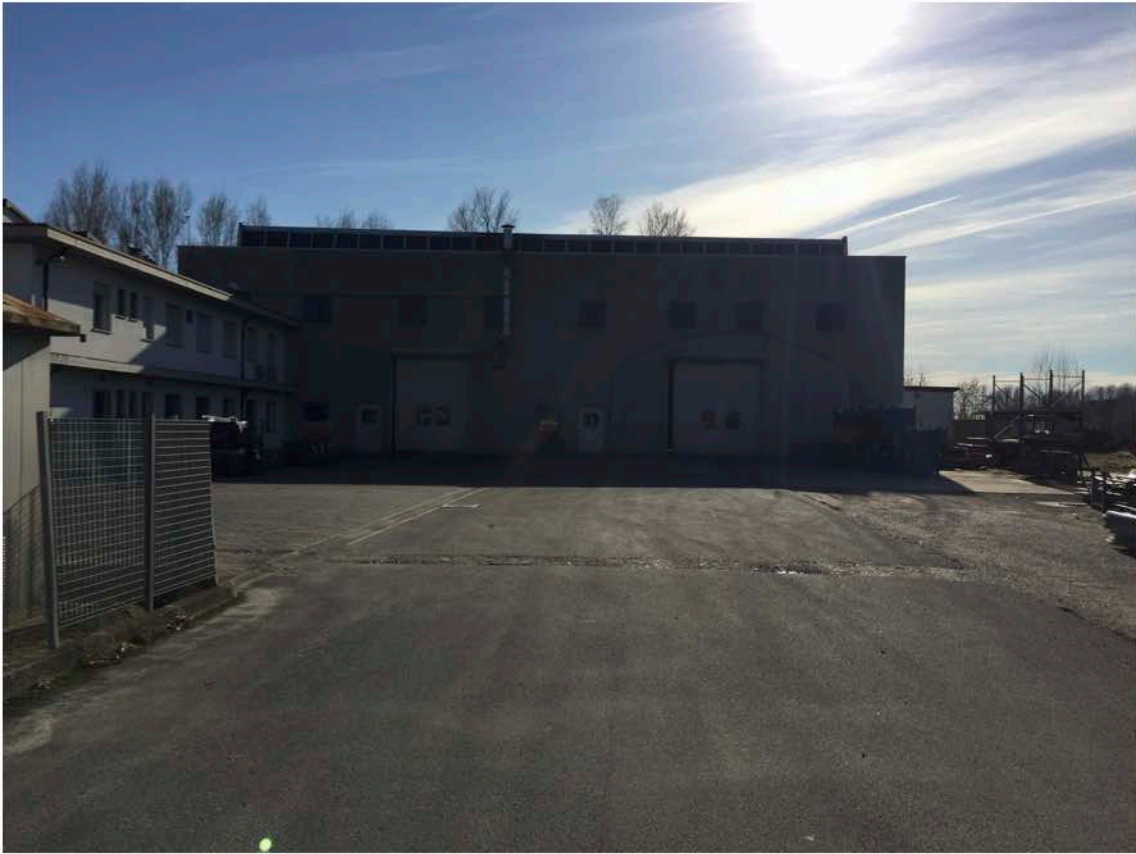
6 - Vista lato nord officina
