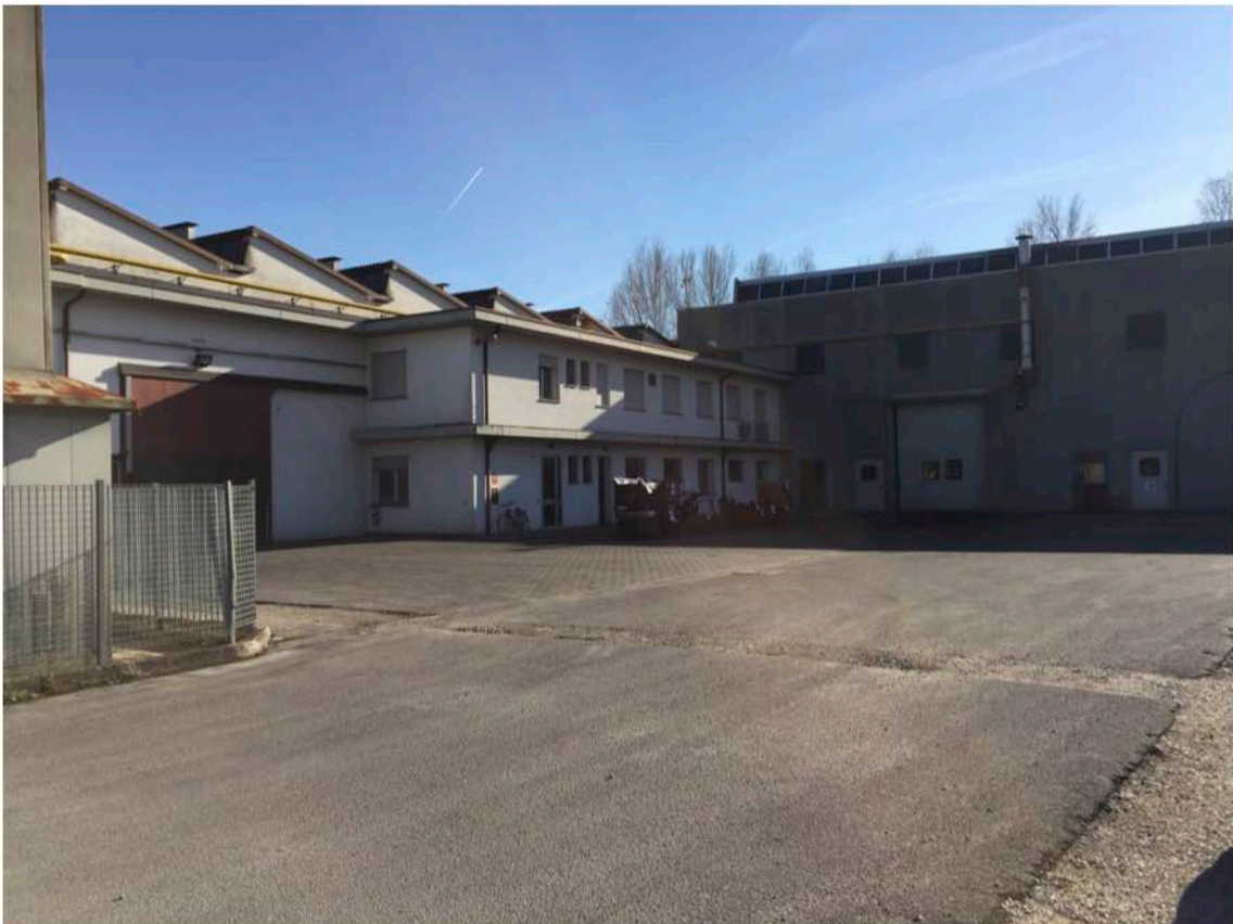
5 - Vista lati nord/ovest
