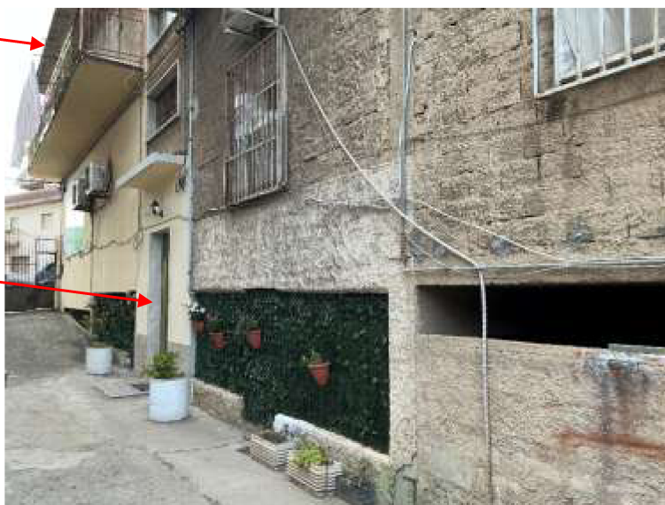
Foto 2: Vista fabbricato dalla corte interna.
