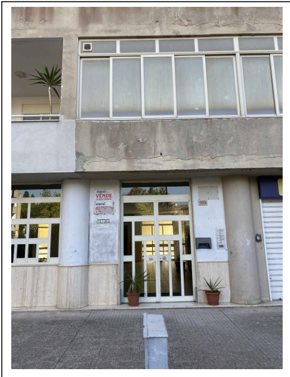
Fotografia n. 2 – Esterno Civico N. 189 - Scala B
