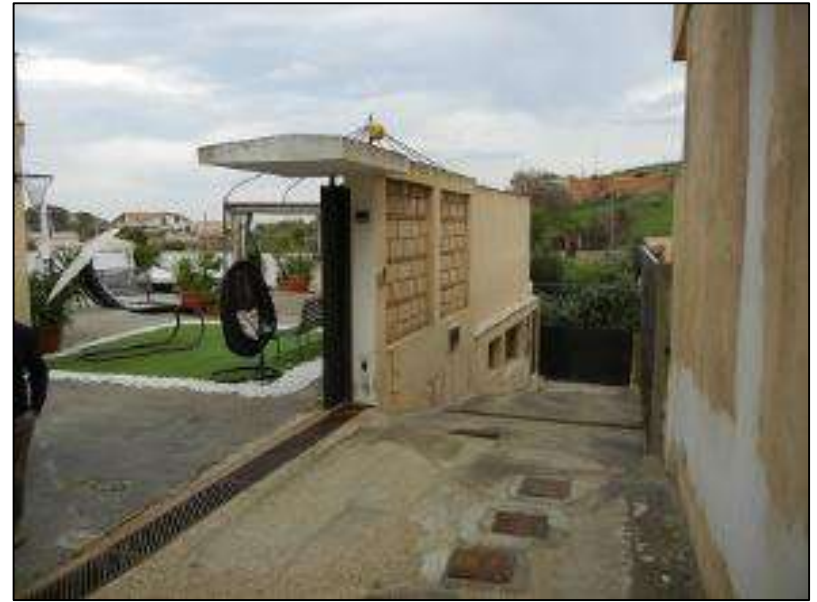
Foto n 6 Strada privata di accesso
