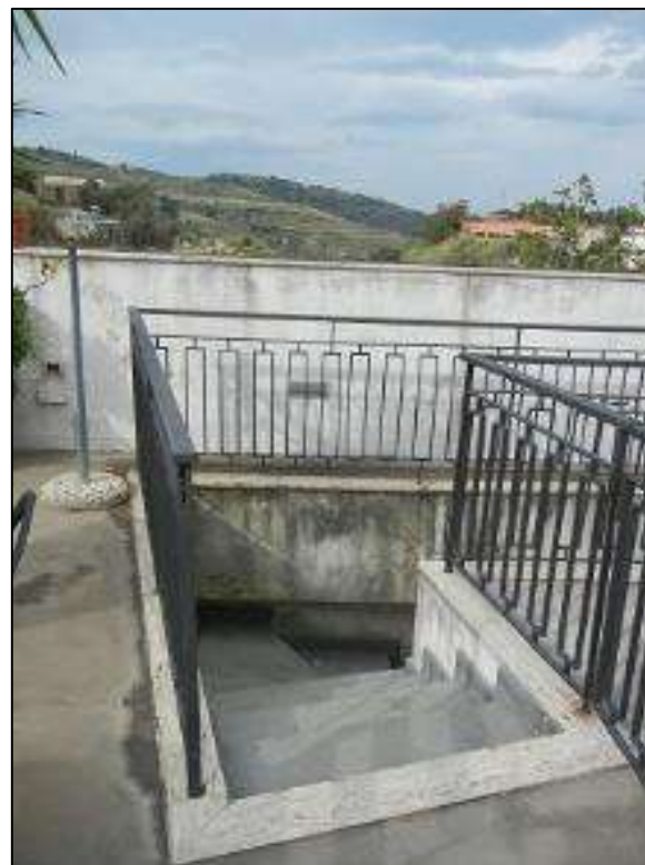
Foto n 28 scala di accesso al p.S1
