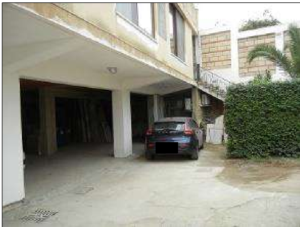
Foto n 25 prospetto Piano S1-S2
