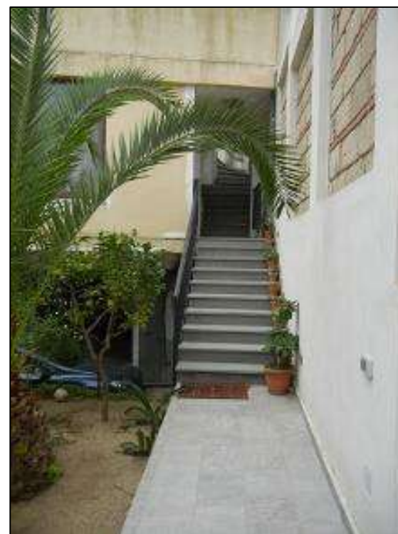
Foto n 26 scala di accesso p. S1
