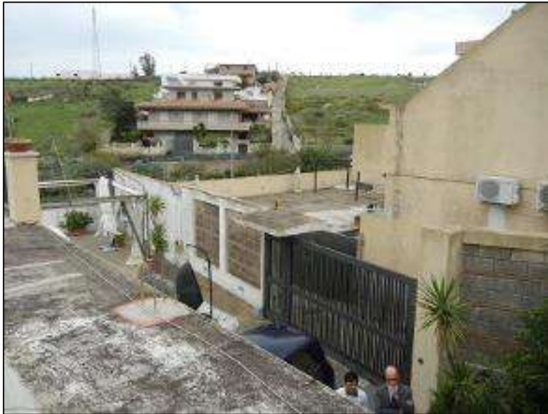
Foto n 5 Cannello ingresso lato Est
