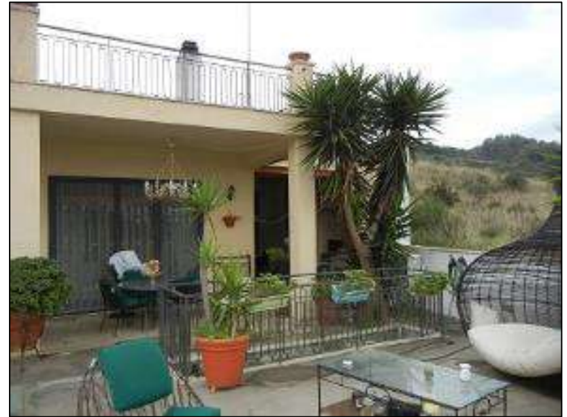
Foto n 4 Prospetto Nord
