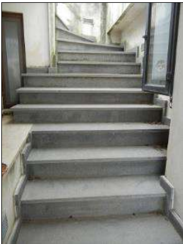
Foto n 27 di accesso al piano S1
