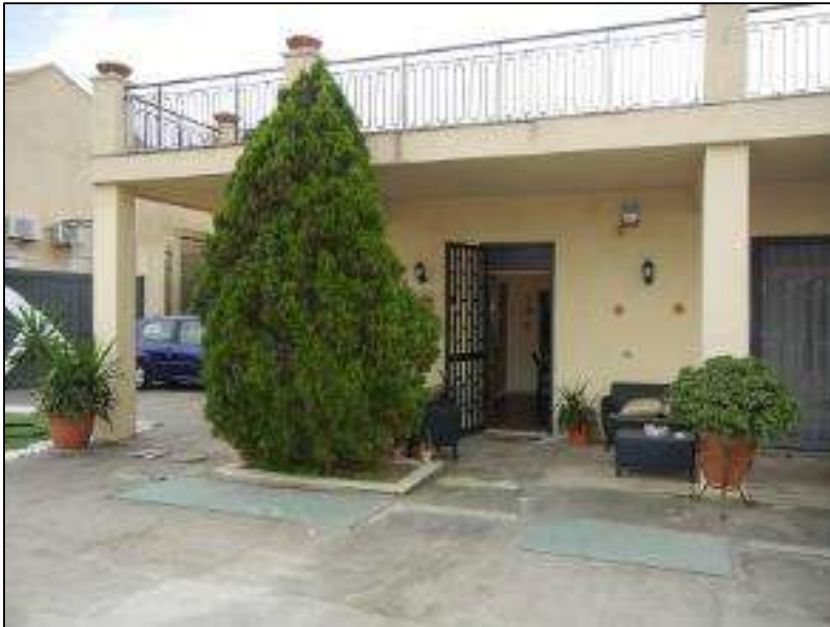
Foto n 3 Prospetto Nord
