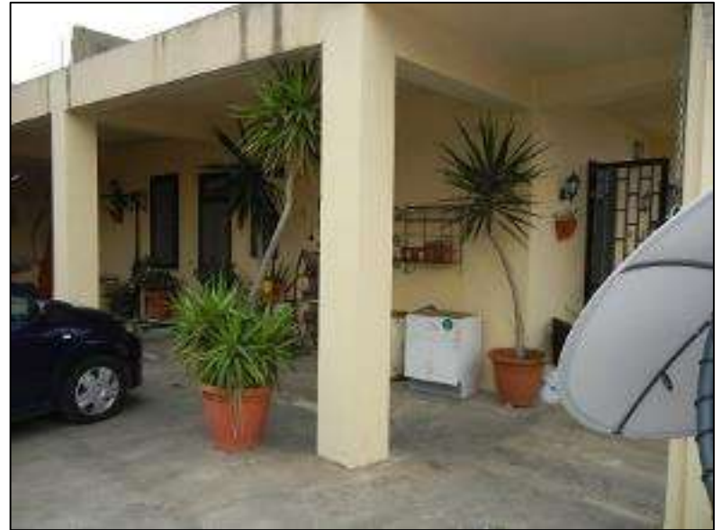
Foto n 2 prospetto Est
