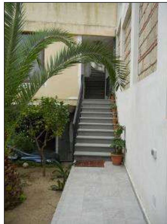
Foto n 26 scala di accesso p. S1
