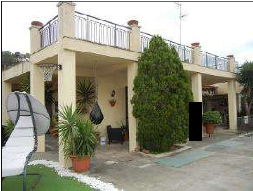
Foto n 1 Prospetto Est
