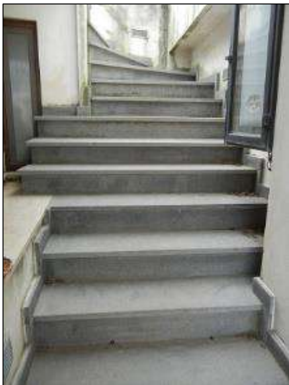
Foto n 27 di accesso al piano S1
