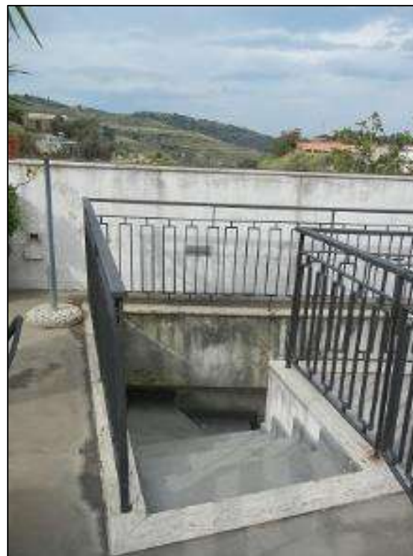
Foto n 28 scala di accesso al p.S1
