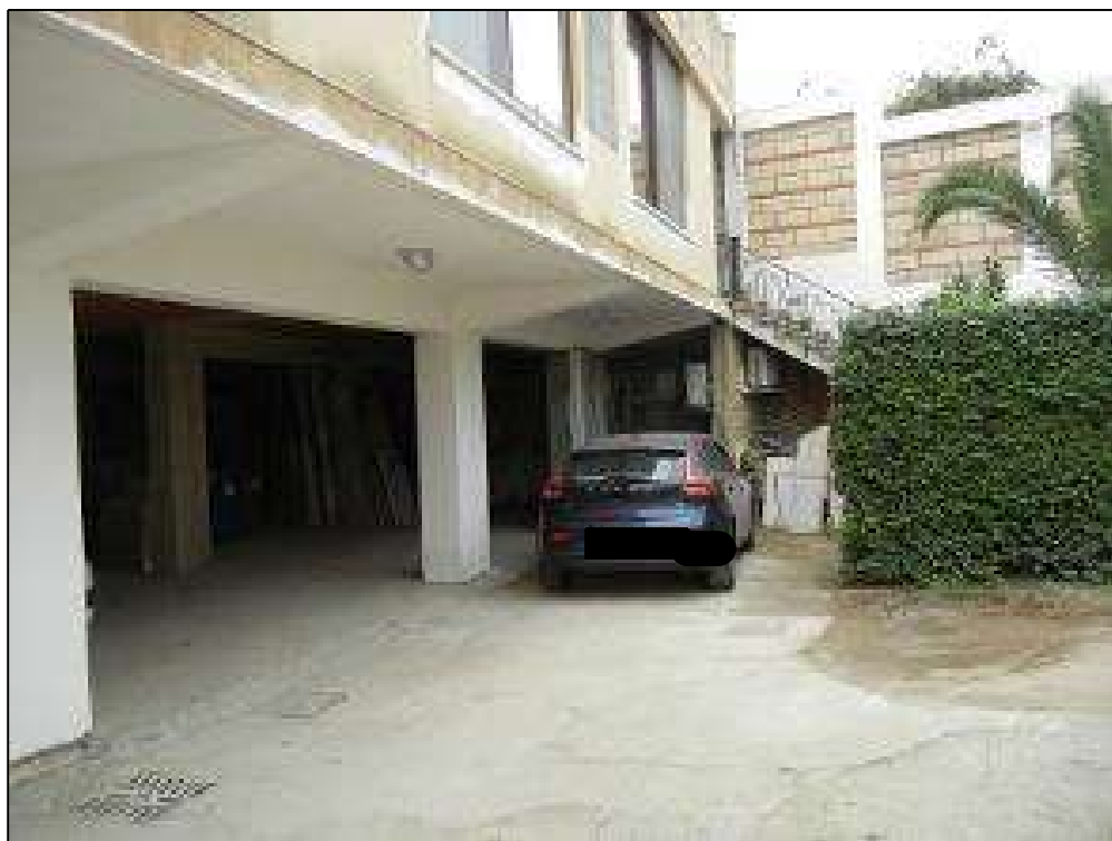
Foto n 25 prospetto Piano S1-S2
