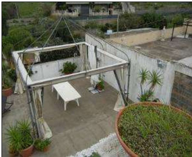
Foto n 21 corte lato est
