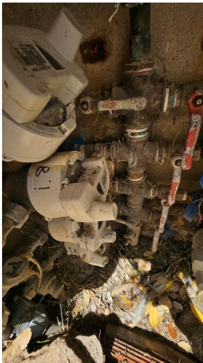
Vista allaccio contatore rete idrica
