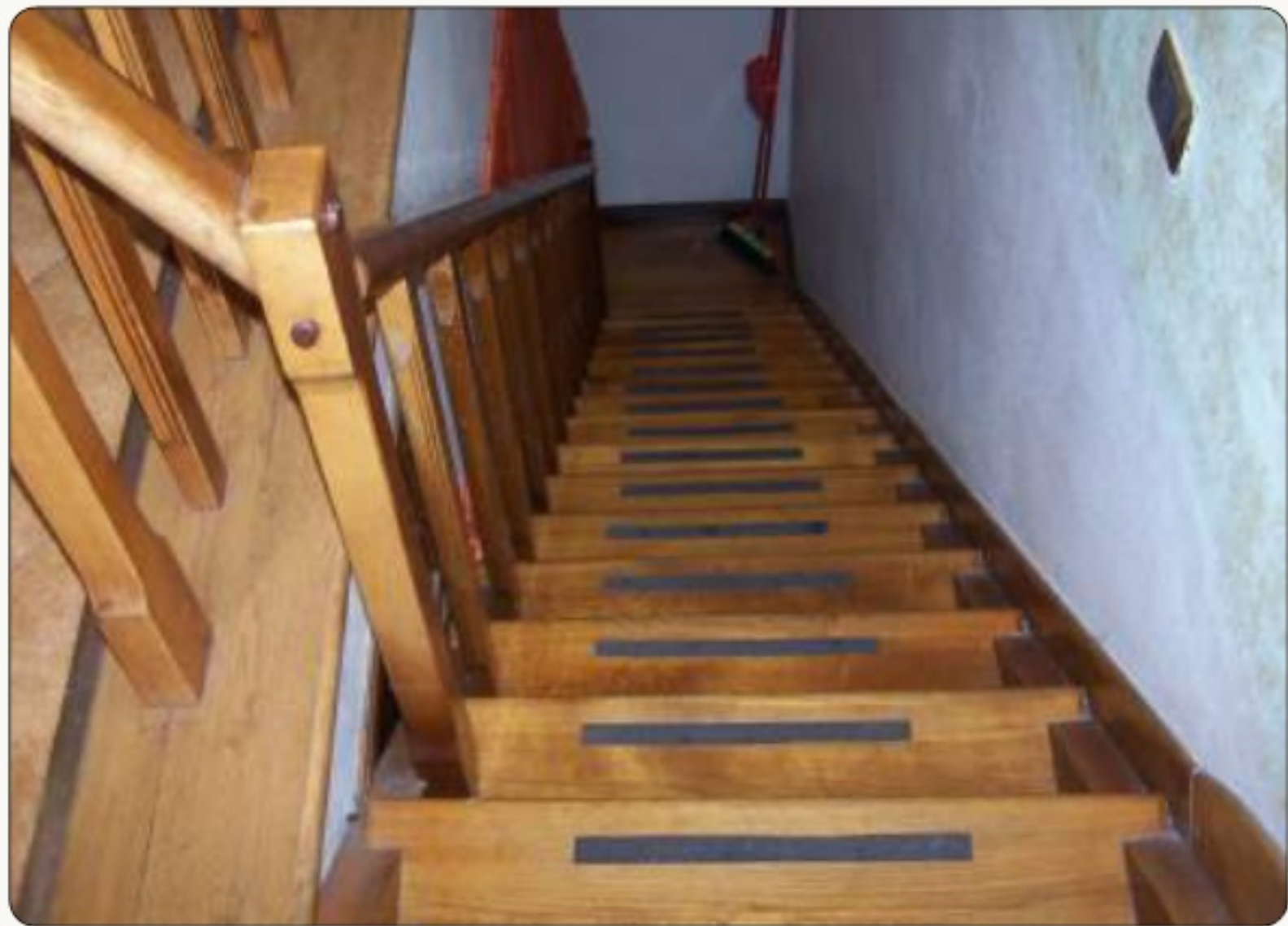
ista della scala dal piano secondo
