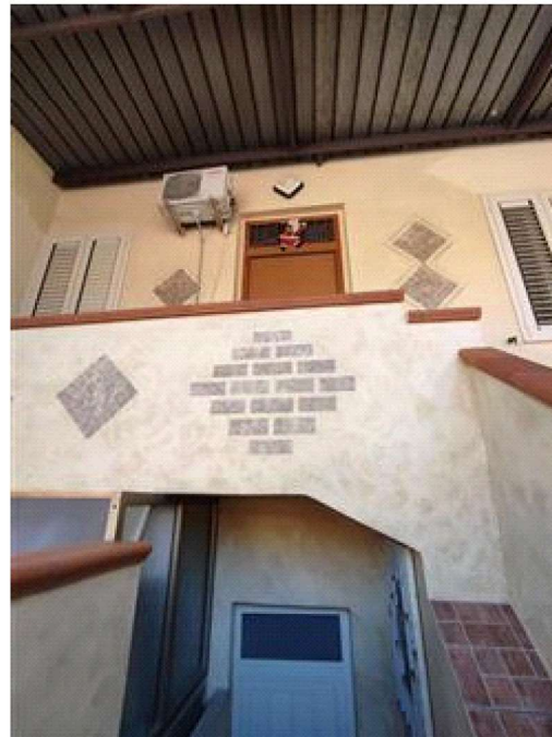
Accesso immobile al 1° piano dalla scala sul retro del fabbricato
