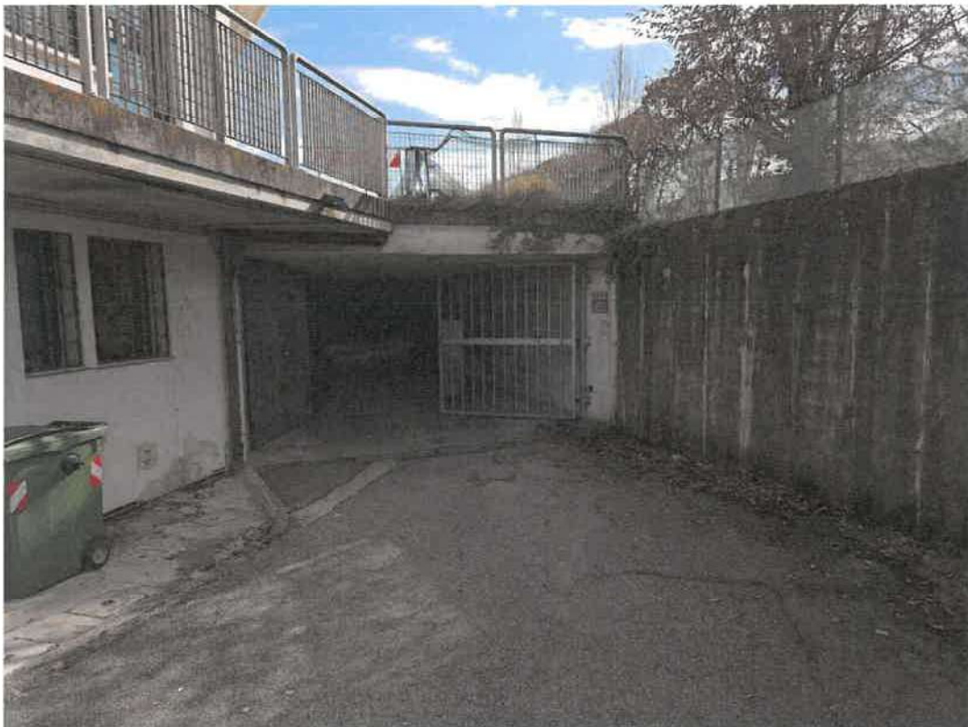
Foto n. 4 : C.F. Fg. 48 mapp. 1027 - Rampa di accesso al piano sottostrada
