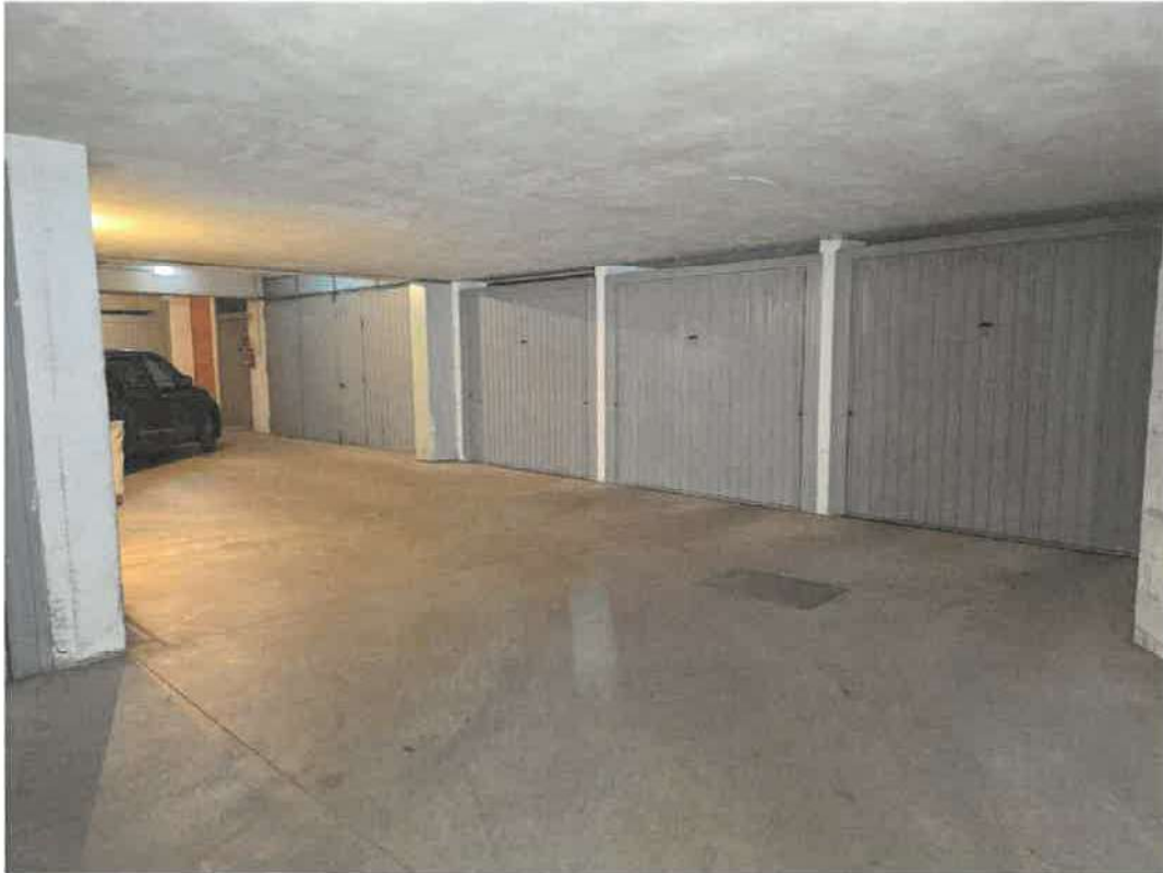
Foto n. 3 : C.F. Fg. 48 mapp. 1027 sub 26 - Aree di manovra, piano sottostrada
