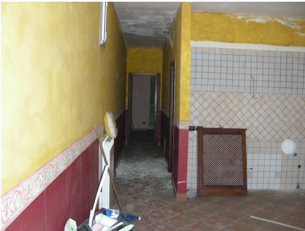
Foto n.22: Corridoio e angolo cottura posto all'ingresso
