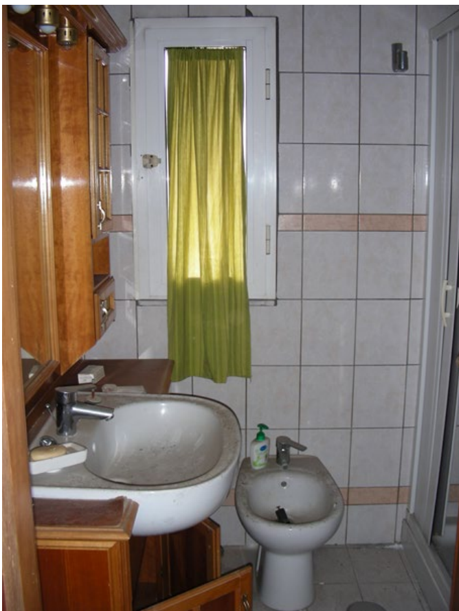
Foto n.48: Bagno a servizio del vano sottotetto
