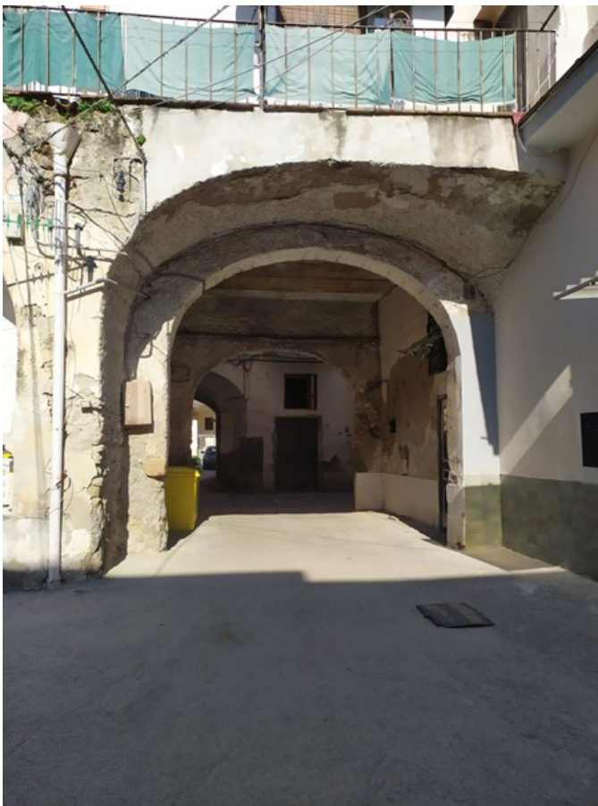
Foto n.6: Androne visto dal cortile
