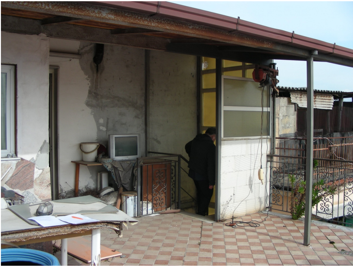
Foto n.39: Arrivo della scala in ferro al terzo piano
