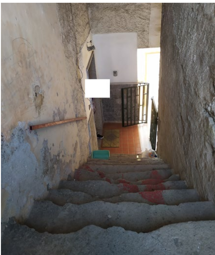
Foto n.12: Rampa di accesso al terzo piano
