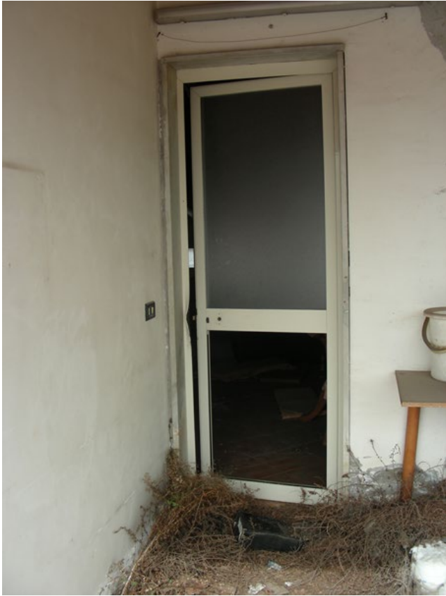
Foto n.43: Porta d'ingresso al vano sottotetto
