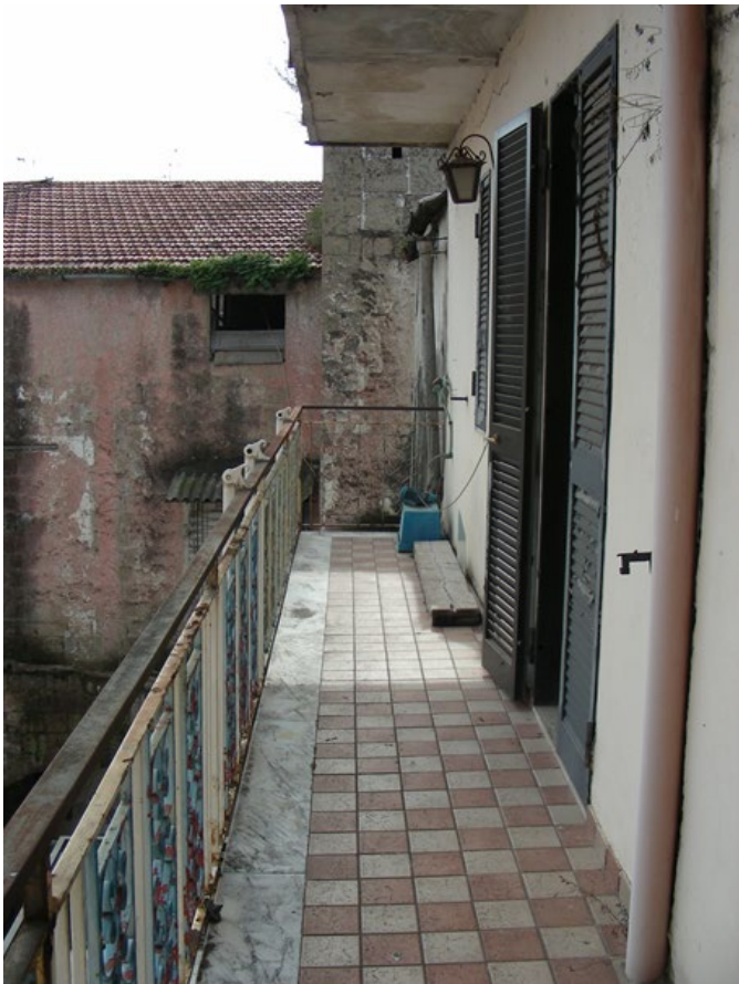
Foto n.37: Balcone dell'appartamento secondo piano
