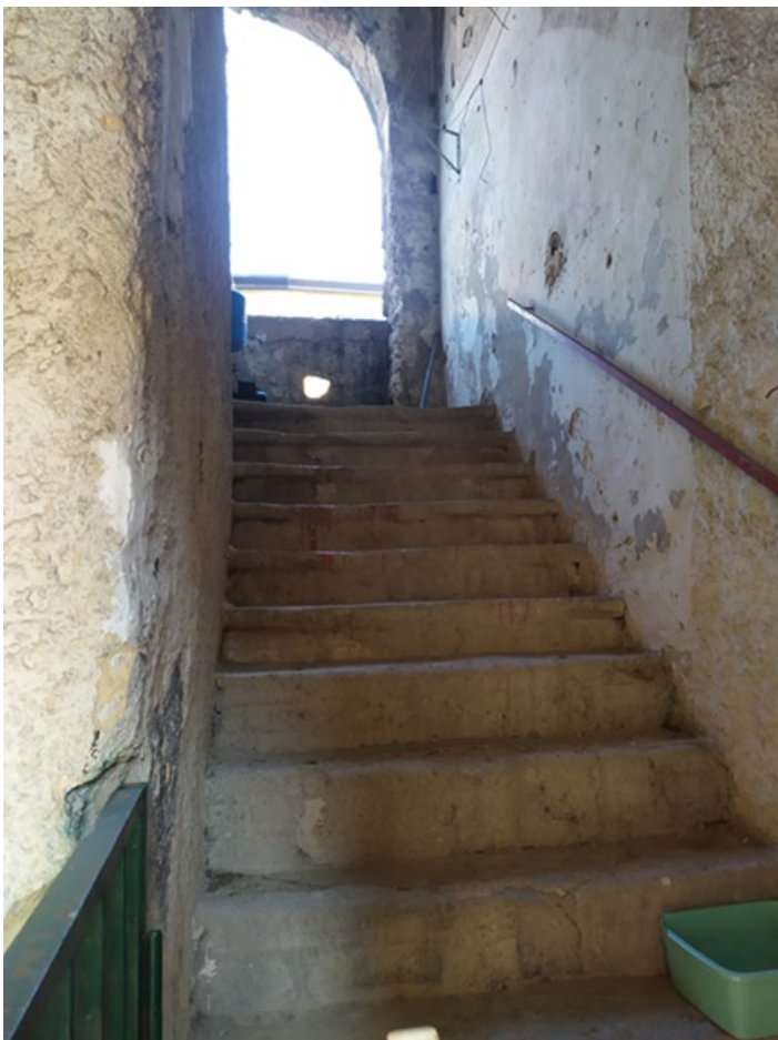
Foto n.11: Rampa di accesso al secondo piano
