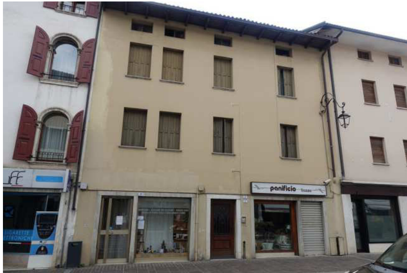
Vista principale fabbricato
