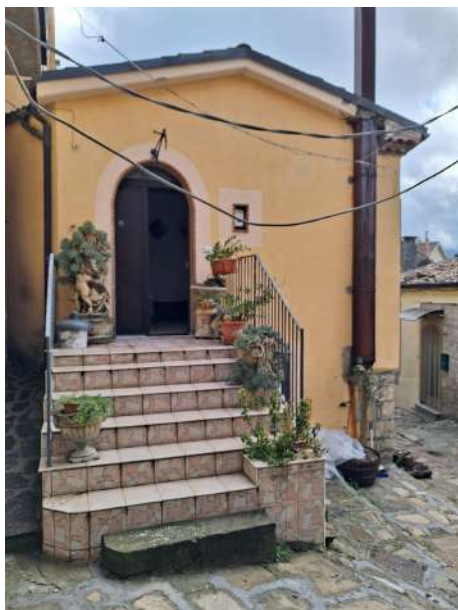
Vista del fabbricato - facciata nord
