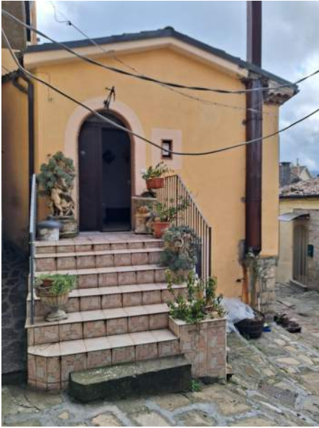
Vista del fabbricato - facciata nord
