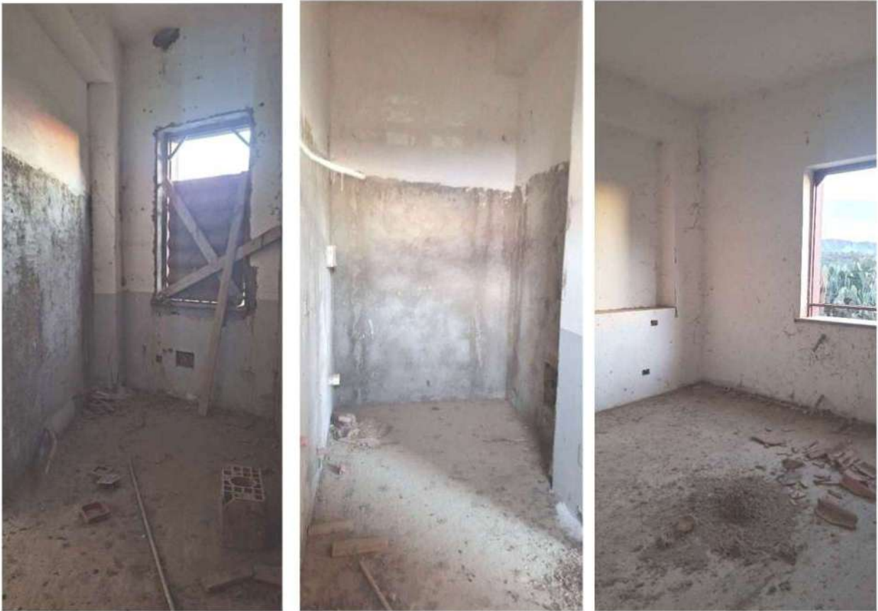
Vista del bagno e della stanza su strada al piano seminterrato
