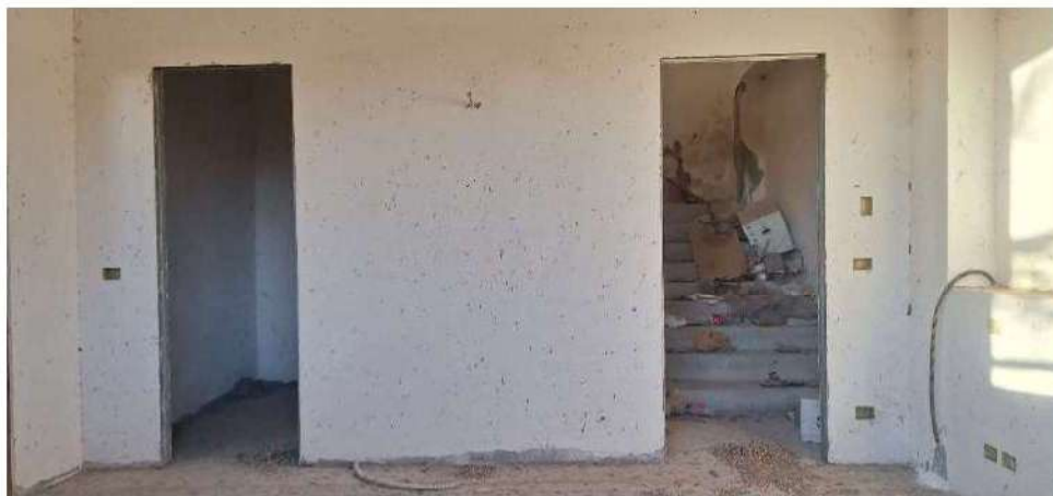
Vista della porta che conduce dalla scala alla stanza al piano seminterrato e della porta della cabina armadio
