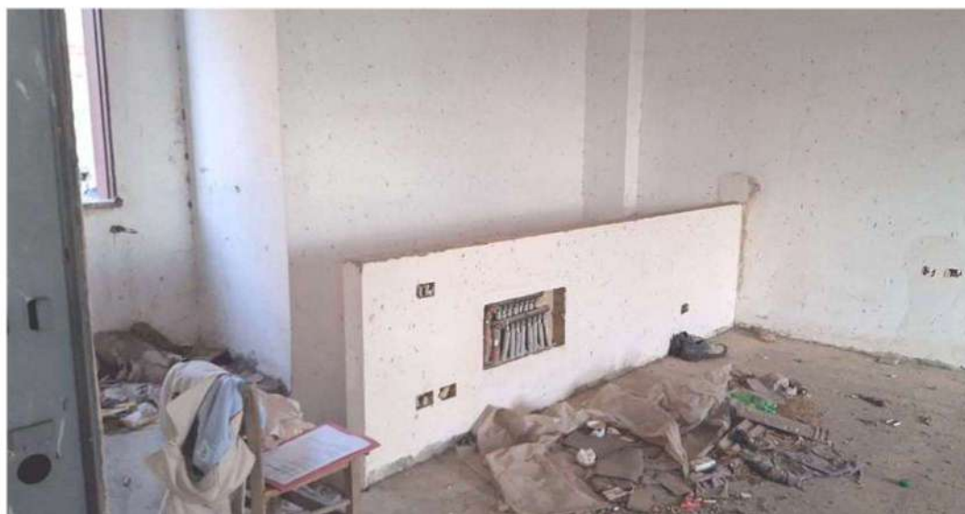
parapetto della scala che collega il piano terra con il piano seminterrato
