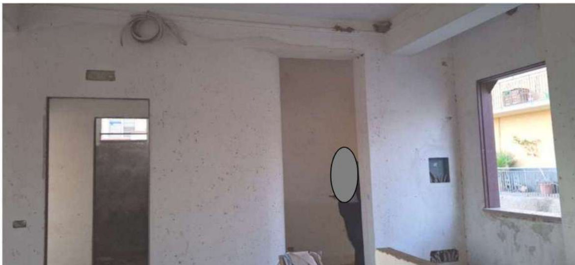
Vista della porzione di disimpegno d'entrata, finestra del salone e finestra alta nel bagno
