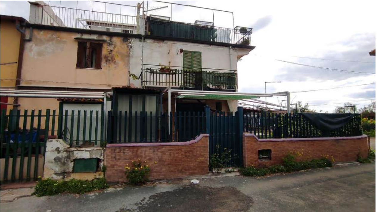
Foto n.1 – Visione dell'esterno dell'immobile – Prospetto Principale
