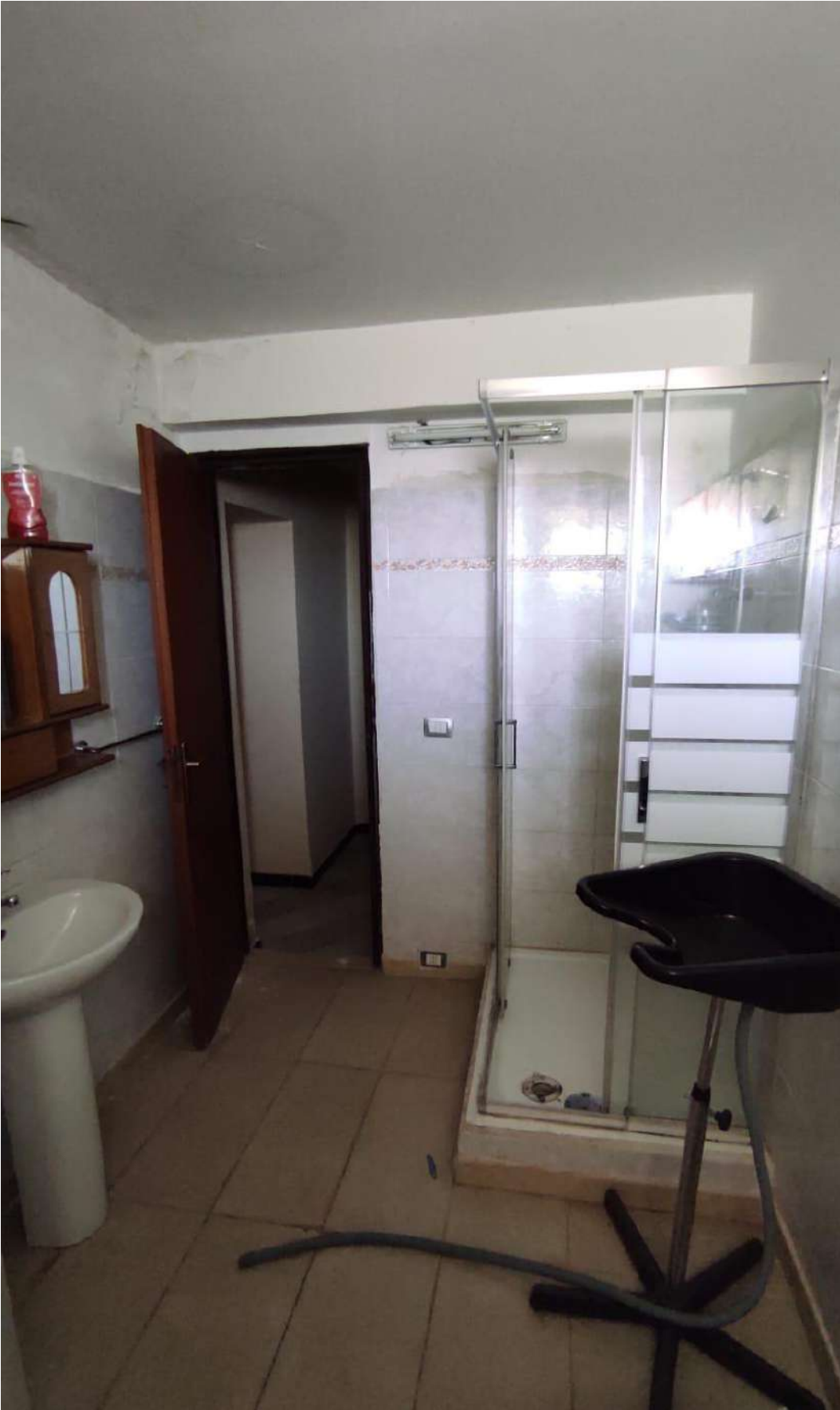
Foto n.7– Vano Wc a P.1°
