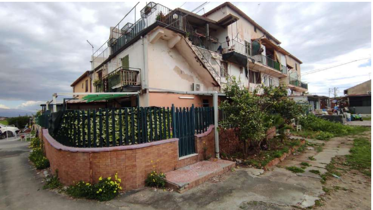
Foto n.2 – Visione dell'esterno dell'immobile –Prospetto laterale
