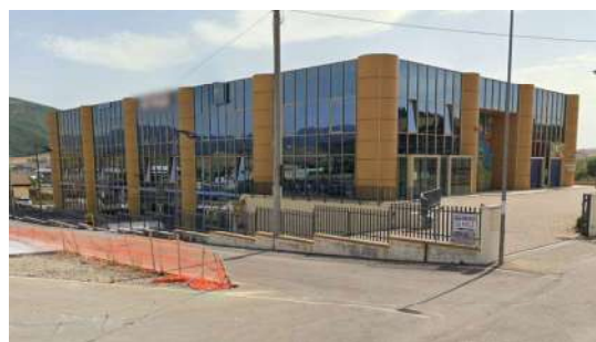
Prospetto laterale sinistro
