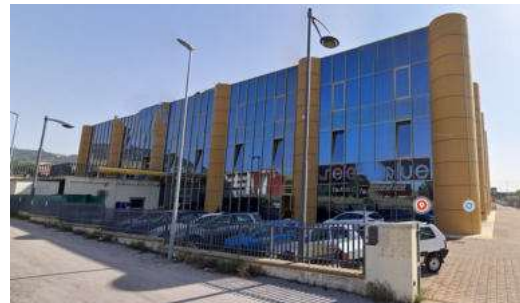
Prospetto laterale destro
