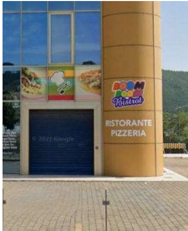
Ingresso dal prospetto anteriore
