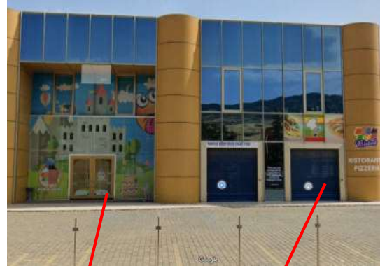
Ingresso ludoteca – ingresso ristorante
