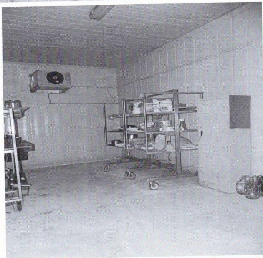
LOCALE CELLA DI STAGIONATURA E CONFEZIONAMENTO
